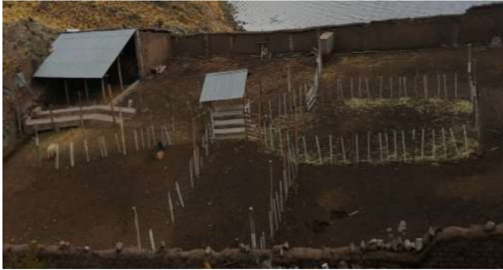
Figura 2. Infraestructura productiva del Centro de Investigación y Producción Quimsachata
