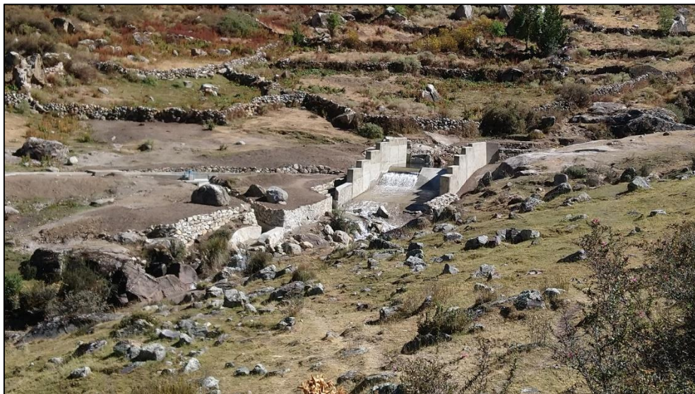
Figura 24: Vista general de la Bocatoma en funcionamiento y ambas márgenes del Cauce principal del Río Santa Rosa
