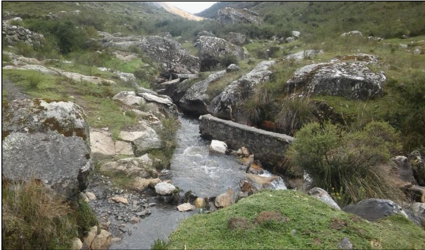
Figura 10: Toma directa existente, antes de la construcción de la Bocatoma
