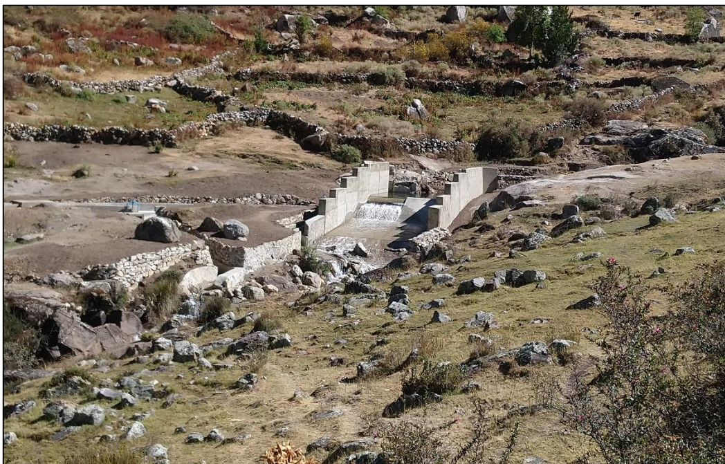
Figura 57: Vista panorámica de la Bocatoma tipo tirolesa, construida y en funcionamiento
