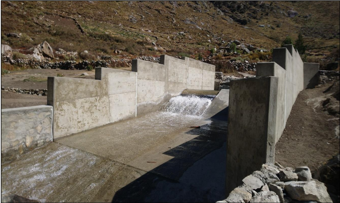
Figura 55: Fotografía de Bocatoma tipo tirolesa construida en funcionamiento
