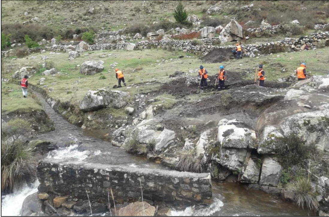
Figura 61: Toma directa, vista antes de la construcción de la Bocatoma tipo tirolesa
