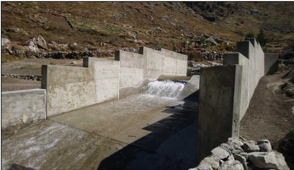
Figura 11: Bocatoma tipo tirolesa, estructura actual
