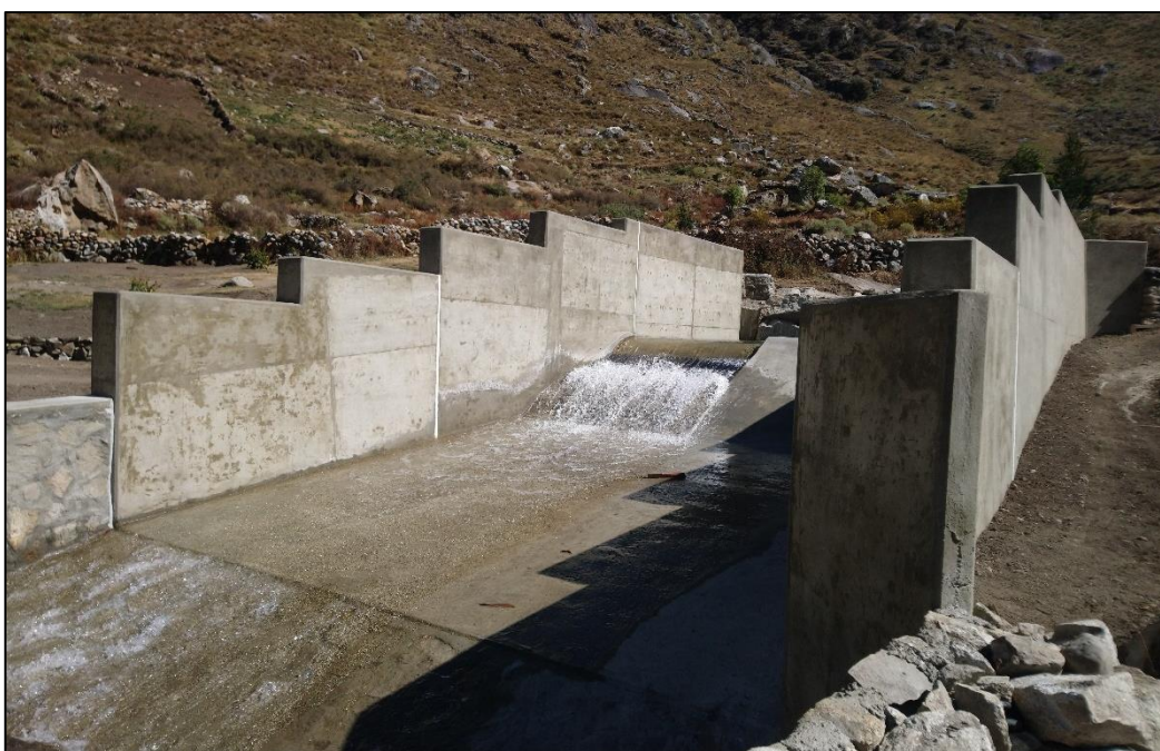
Figura 58: Vista aguas arriba de la Bocatoma tipo tirolesa, en funcionamiento
