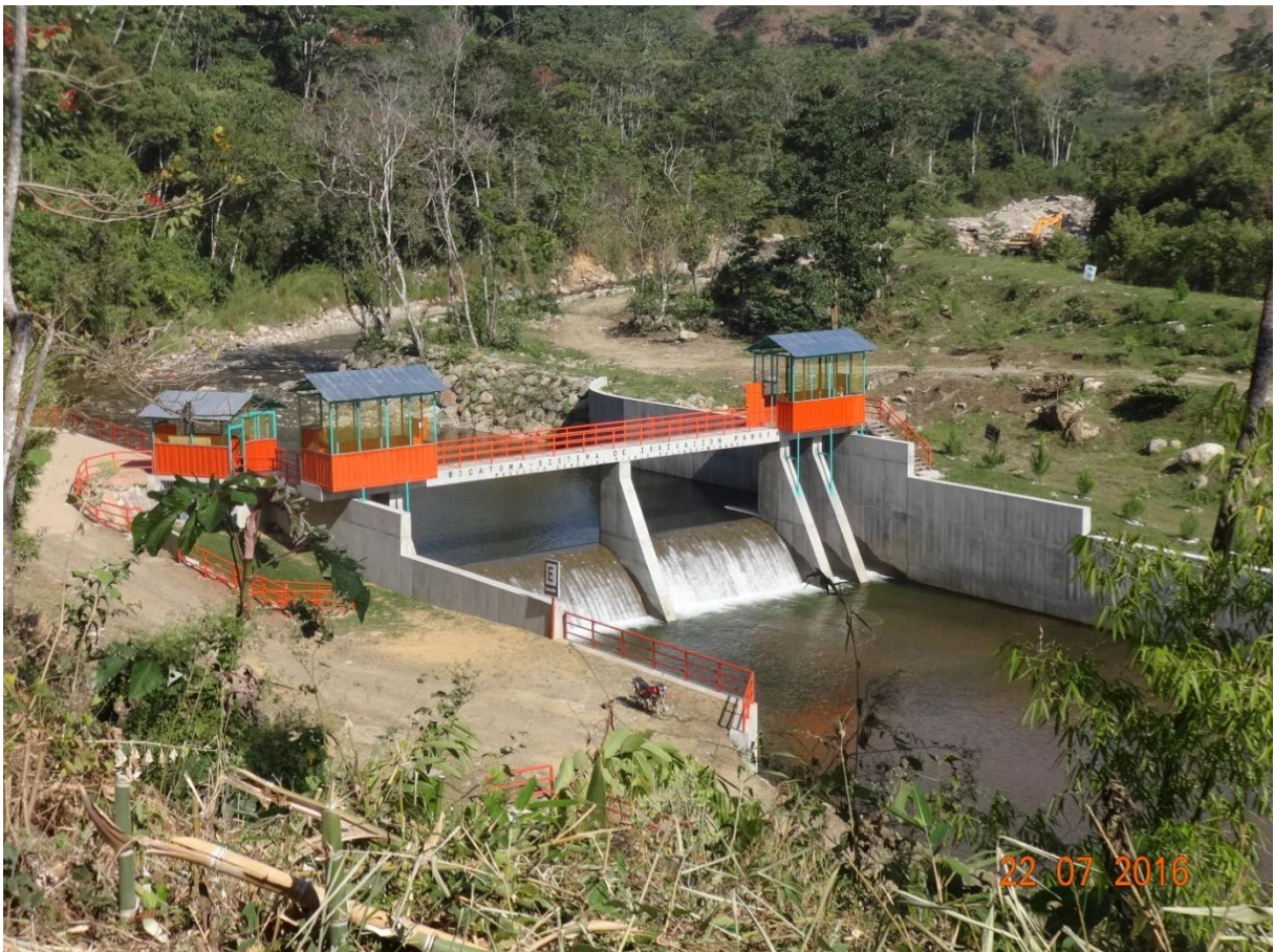
Figura 5: Bocatoma "San Ramón" del Sistema de Irrigación Pangoa
