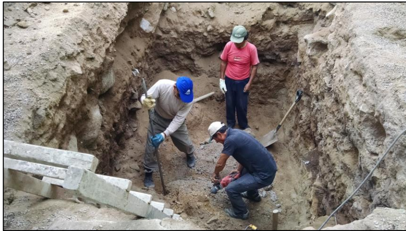
Figura N°12. Excavación para la construcción del tanque séptico
