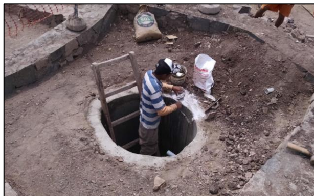
Figura N°17. Construcción del reservorio final de agua tratada
