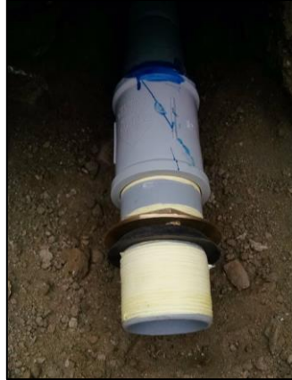
Figura N°15. Tubo de PVC de 2" de diámetro unido a un niple cubierto de cinta teflón y con una contratuerca y una empaquetadura ya enroscadas
