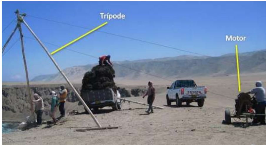
Figura 39: Descripción básica del sistema de wincheo, un trípode que sostiene las poleas y el motor operado por un winchero
