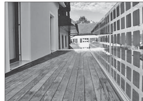
FIG. 2 HOUSE IN STARRKIRCH-WIL: BEFORE RECONSTRUCTION, AFTER RECONSTRUCTION, SOUTH BALCONY WITH PV PANELS FENCE SL. 2. KUĆA U STARRKIRCH-WILU: PRIJE REKONSTRUKCIJE, NAKON REKONSTRUKCIJE, JUŽNI BALKON S OGRADOM OD FN (FOTONAPONSKIH) PANELA
