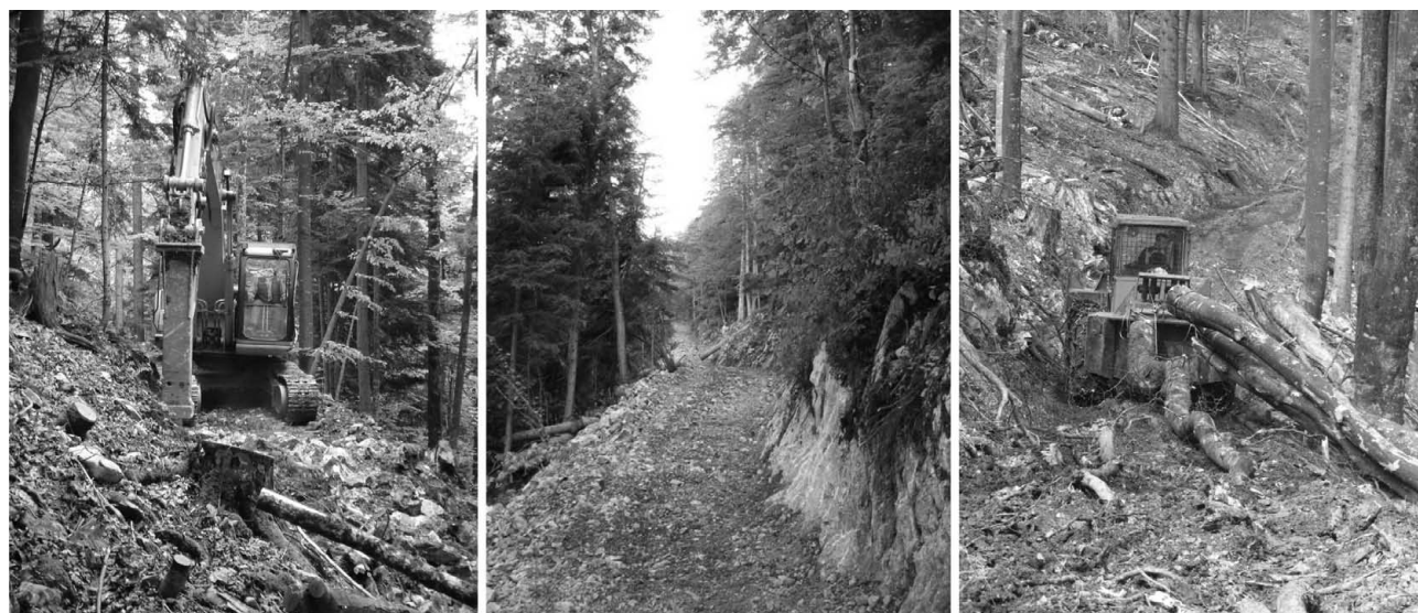
Slika 8. Gradnja traktorskoga puta na teškim terenima omogućuje kretnost skideru
