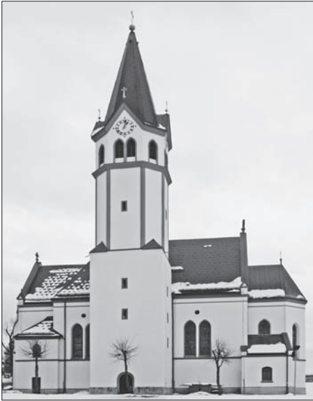
Sl. 23. ŽUPNA CRKVA U MIRNOJ PEĆI FIG. 23. PARISH CHURCH IN MIRNA PEĆ
