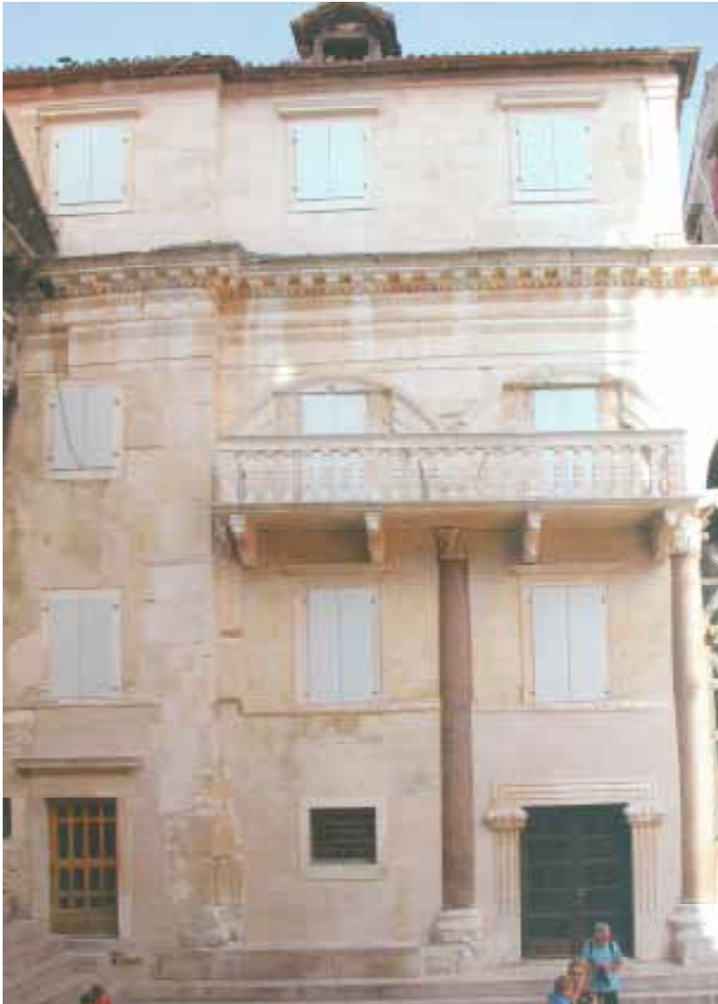
slika 11. Pročelje palače nakon restauratorsko-konzervatorskih zahvata
