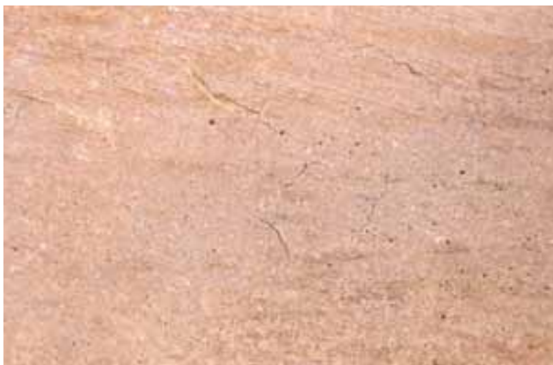
slika 8. Tragovi četke po svježoj žbuci
