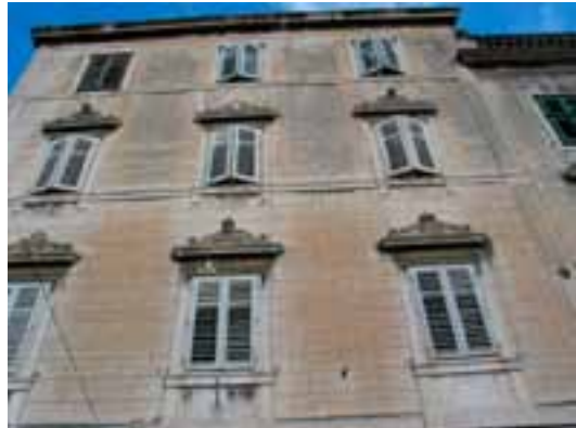
slika 4. i 5. Primjeri slijepih sljubnica na pročeljima
