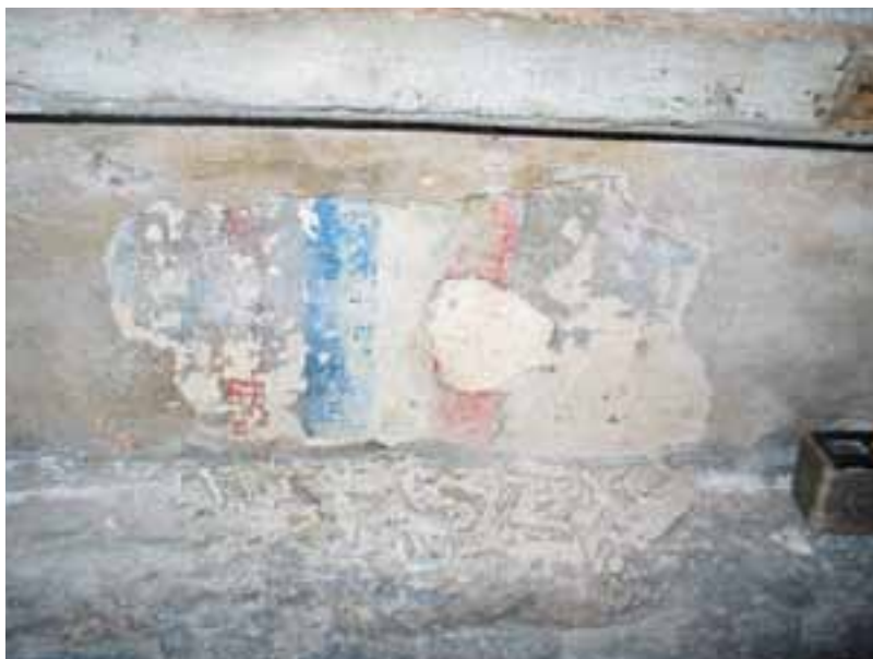
slika 7. Tragovi prijašnjih bojanih slojeva žbuke
