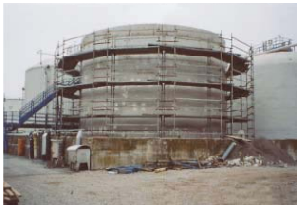
Figure 11. Erection of the storage-tank shell Slika 11. Montaža plašta rezervoara
