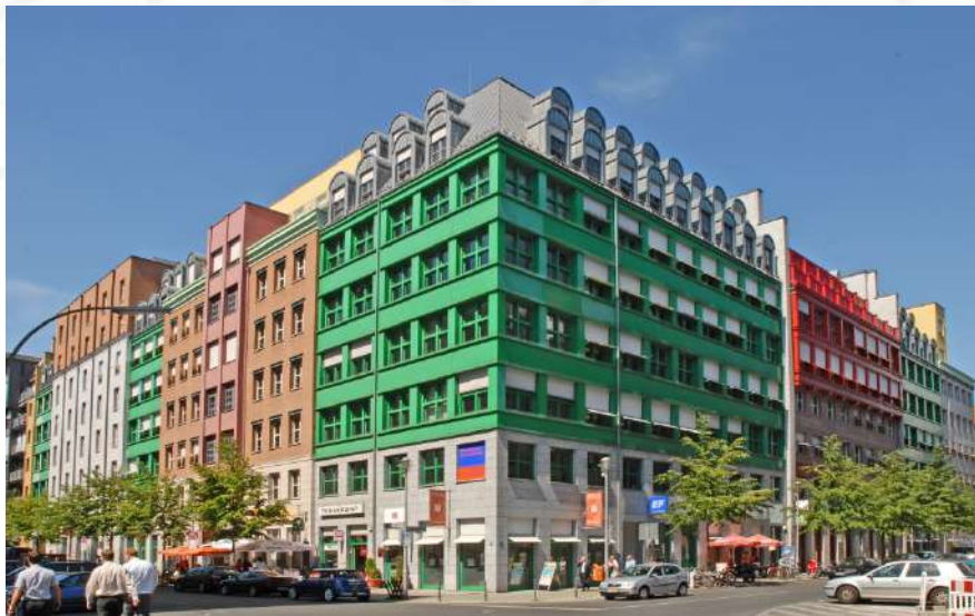
Fachadas del Quartier Schützenstrasse
