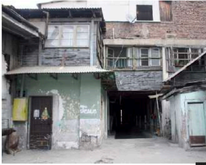
1. Patio interior del cité de Santo Domingo 2426. 2. Escalera al tercer piso del cité. 3. Interior del cité, piezas del primer piso.
