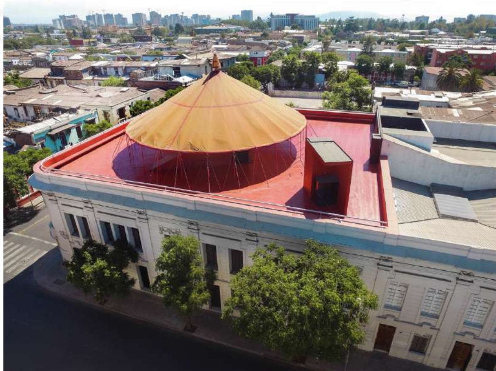
Vista aérea de NAVE
