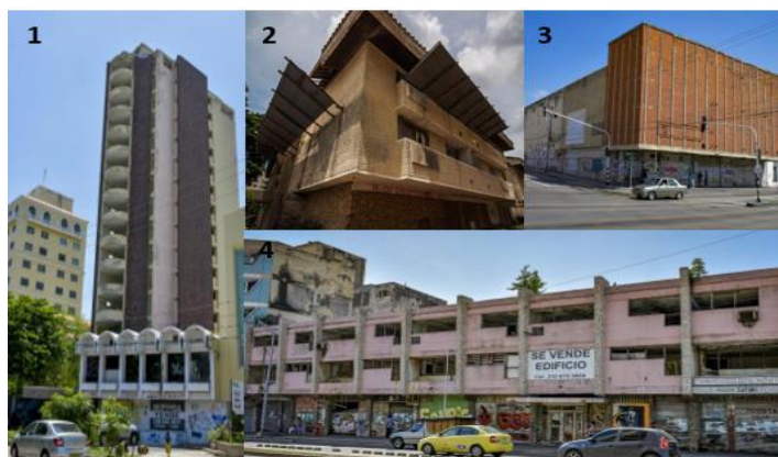
Figura 1. Estructuras corroídas en Barranquilla. Fuente: Narváez, V. (2018). https://www.elheraldo.co .
