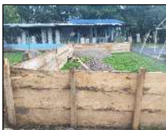
Figura 36. Construcción de aulas. Fuente: Elaboración propia (2021).
