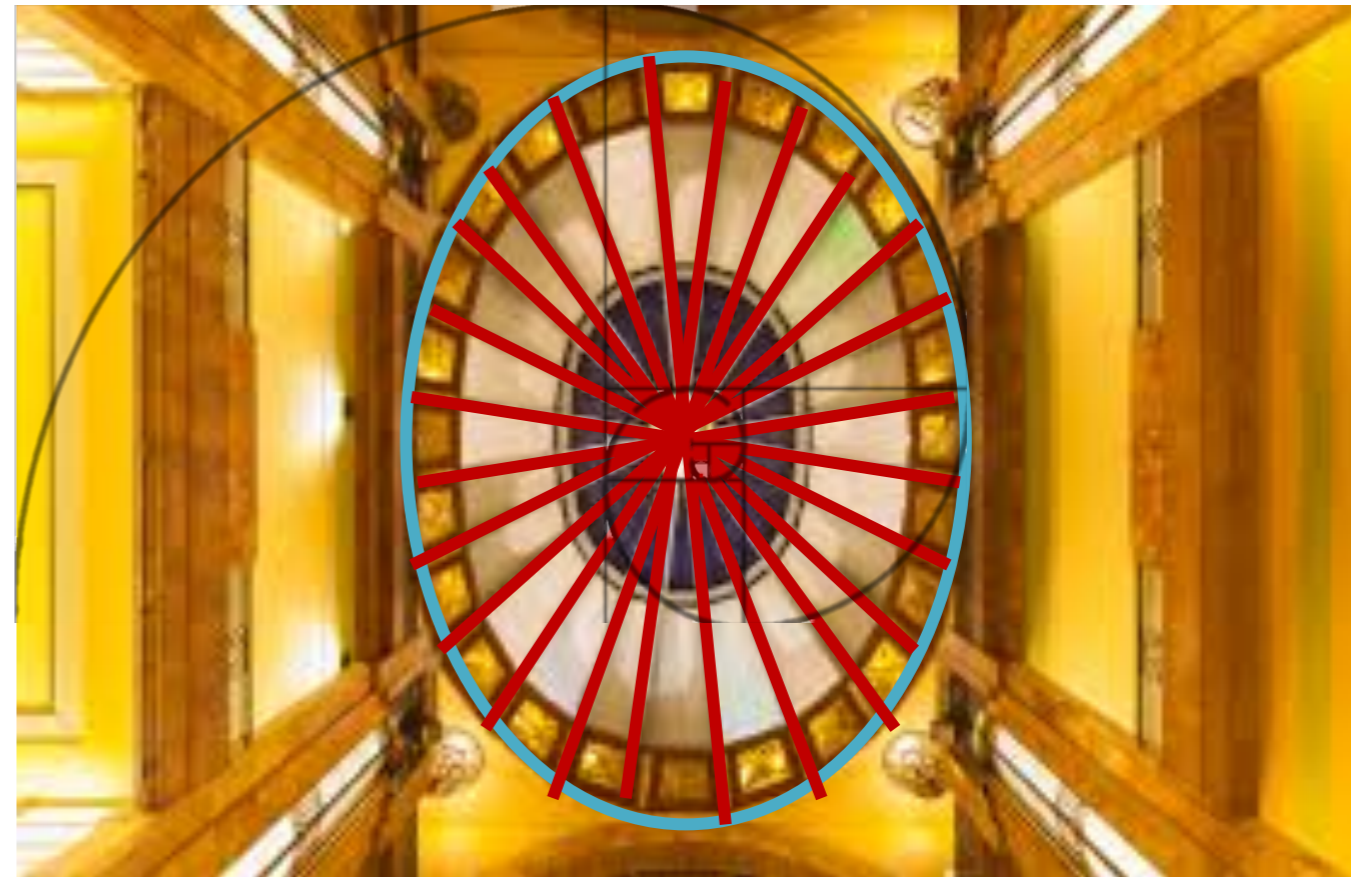
VISTA INTERIOR DE LA CÚPULA
