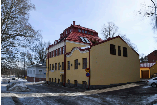
Kuva 101. Keskuskoulun korttelissa sijaitseva entinen Kunnallissaunan rakennus, joka on peräisin 1910-luvulta. Rakennus toimi saunana 1960-luvulle asti, nykyään se toimii toimisto- ja liiketiloina.
