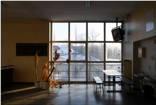
Kuva 94. Luokkahuonesiiven eteläpään ikkuna tuo valoa keskikäytävään. radiaattorisyyvennys ja vesipistesyyvennykset aloittavat keskikäytävän naulakosyyvennysten rytmin.
