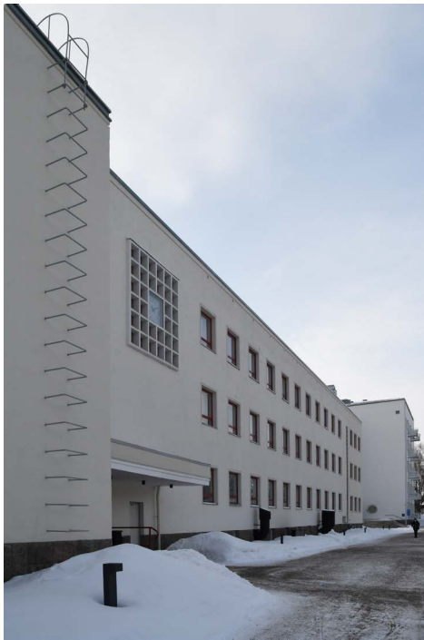
4 Kuva 36. Rakennuksen julkisivuväritys ei ole alkuperäinen, mutta noudattaa funktionalismin ominaispiirteitä. Julkisivut muodostuvat suurista vaaleista pinnoista, joiden yksityiskohdat ovat korostettu vahvoin värein.
