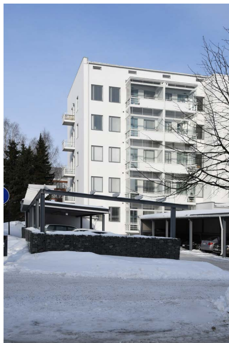
5 Kuva 50. Sisäpihan puoleiset uudet parveketornit edustavat selvästi nykyajan tyyliä ja heikentävät rakennuksen julkisivujen luettavuutta. Maanpäällisten autokatosten vuoksi kohteeseen ei ole kyetty sijoittamaan ulko-oleskelualueita.
