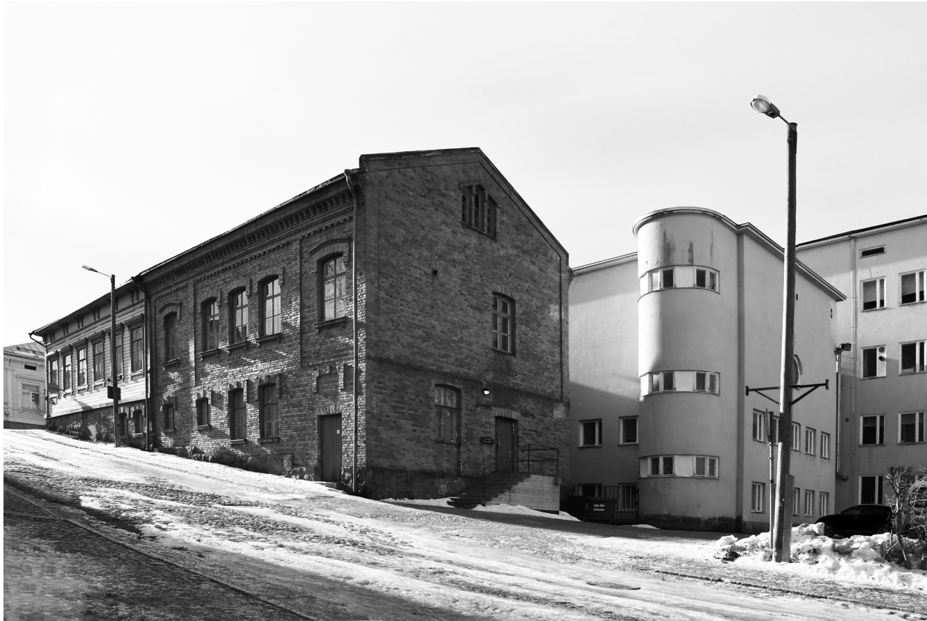
Kuva 66. Gaddin talon tiilinen laajennusosa kuvattuna Linnankadulta. Linnankatu nousee jyrkästi Aleksis Kiven puiston suunnalta kohti Lukiokatua. Rakennuskokonaisuuden tiiliosan julkisivuissa näkyy aikojen saatossa tehtyjä muutoksia aukotuksessa. Esimerkiksi Linnankadun suuntaisen julkisivun pohjoisnurkan umpeen muuratun ikkuna-aukkon alapuolelle sijoitettu oviaukko, joka on muurattu sisäpuolelta umpeen.
