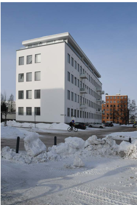
4 Kuva 49. Uudet, väritykseltään vaaleanharmaat, puu-alumiini-ikkunat rikkovat rakennuksen funktionalistista ilmettä. Uusi korotuskerros niin ikään hämärtää funktionalismille tyypillistä eri rakennusosien välistä korkovaihtelua.
