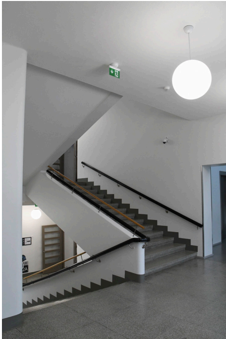
1 Kuva 10. Kunnostettu koulun pääporras. Keskikaidetta on korotettu vastaamaan nykyisiä käyttöturvallisuusvaatimuksia.
