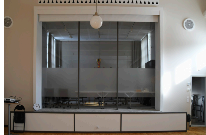
Kuva 25. Liikuntasalin lavalle on rakennettu neuvotteluhuone, jonka uudet metalli-lasirakenteet erottuvat selvästi vanhasta.
