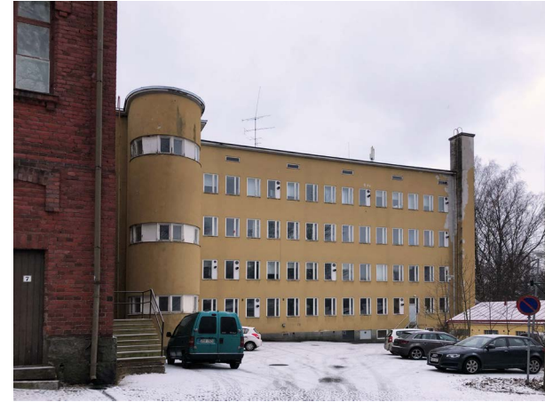
Kuva 82. Näkymä Linnankadulta kohti koulun huoltopihaa ja luokka-huonesiipeä. Liian tiivis ruiskurappaus lohkeilee paikoitellen runsaasti.
