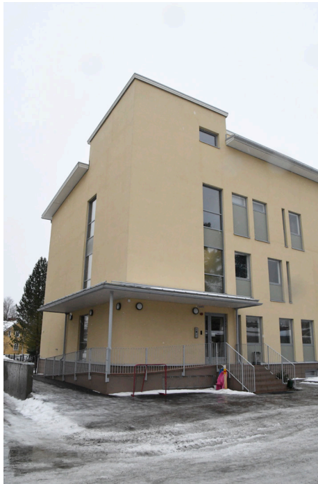
5 Kuva 18. Uudisrakennuksen pääsisäänkäynti on vastakkaisella puolella, kuin entisen koulurakennuksen. Näin toimintojen erillisyyks on vierailijoille selkeää.
