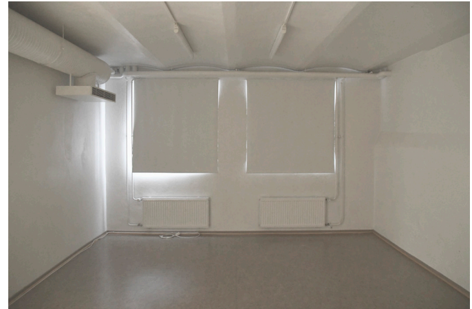
Kuva 71. Pohjakerroksen työtila, välipohjan kappaholvaus on näkyvässä tiililaajennusosan ja alkuperäisen puurakennuksen rajapinnalla.
