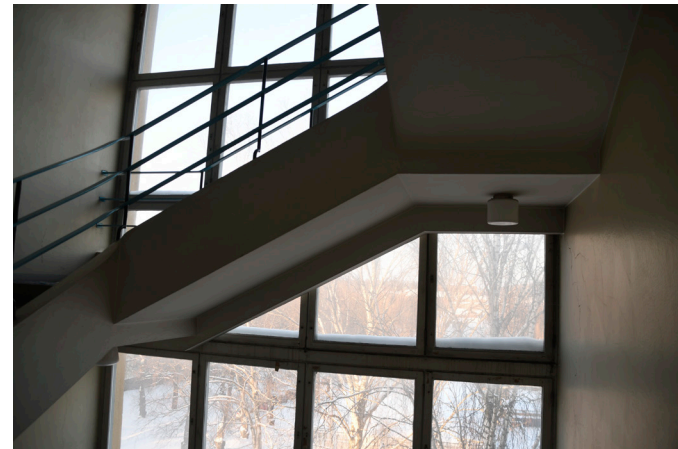
Kuva 95. Opettajan portaan palkkimainen reunaosa antaa portaalle jyrkän, tarkkapiirteisen hahmon. Metalliprofiilikaide puolestaan tekee portaasta ilmavan ja takaa päivänvalon pääsyn keskikäytävään asti.
