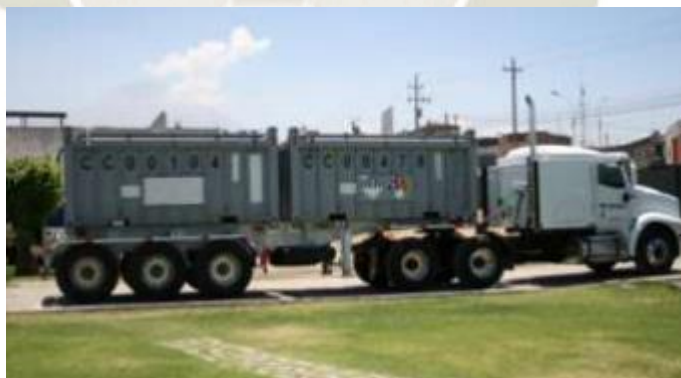
Figura 26. Transporte en camión
