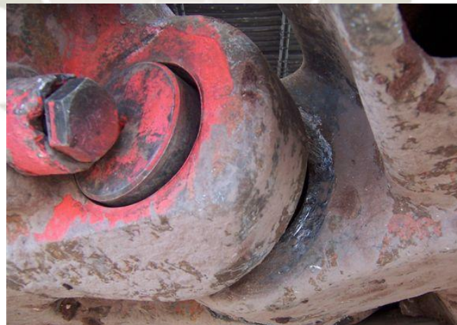
Figura 39. Rotura de pin
