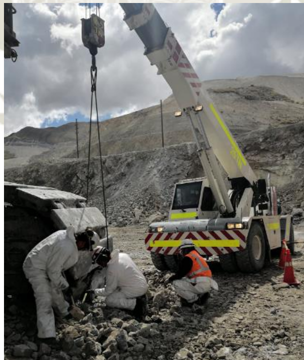
Figura 37. Trabajos de cambio de zapata
