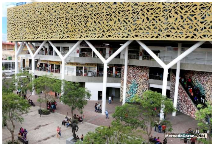
Fotografía 4 Fachada Mercado Corona (Jalisco, México)
