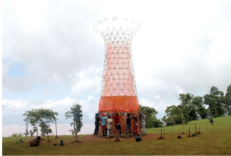
Ilustración 6. Warka Water («Warka Water. La torre de bambú que produce hasta 100 litros de agua al día»,2021).
