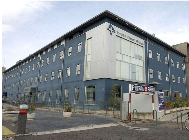
Ilustración 47 Hospital Recoletas Campo Grande.
