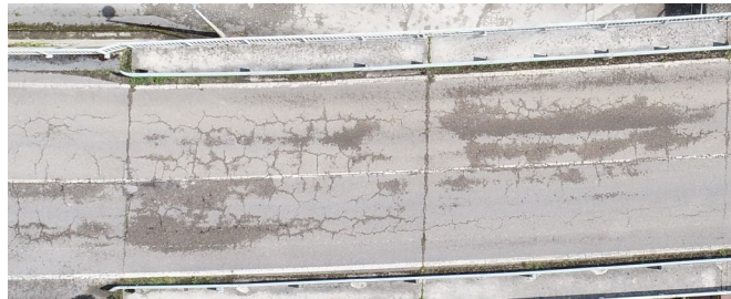
Ilustración 15- Foto de piel de cocodrilo en pavimento tomada por el dron
