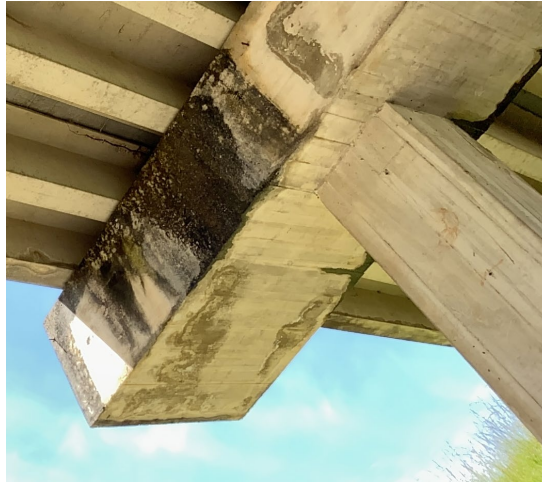
Ilustración 31- Humedades y filtraciones en cargadero 3
