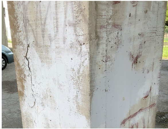
Ilustración 29- Grieta en pila 3
