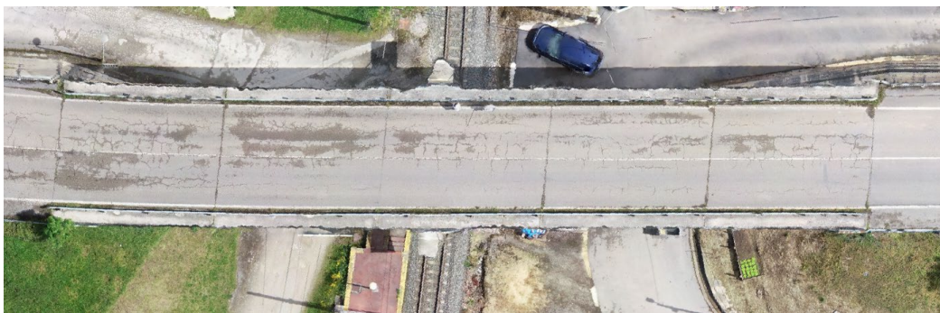
Ilustración 10- Pavimento sobre el pontón
