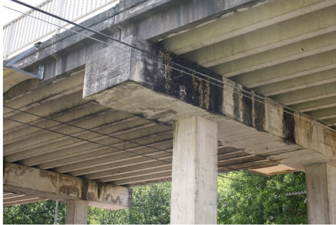
Ilustración 3- Pilas en fuste con cargadero
