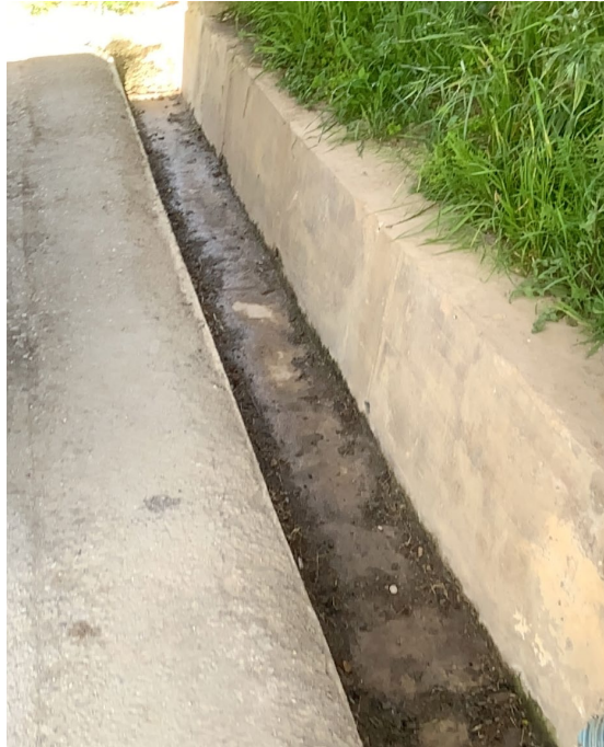
Ilustración 9- Cuneta junto a pila 4
