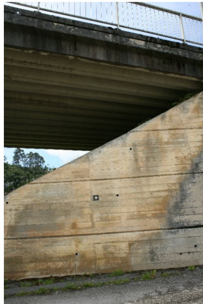
Ilustración 6- Muro lateral en prolongación en el estribo 2
