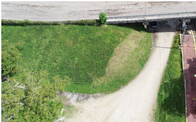
Ilustración 8- Plantaciones sobre terraplén en estribo 2
