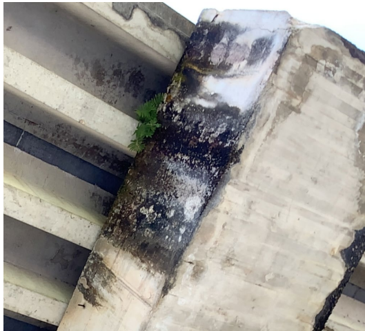
Ilustración 31- Humedades y filtraciones en cargadero 3
