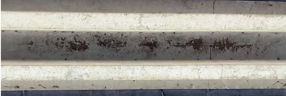
Ilustración 28- Degradación superficial de los vanos
