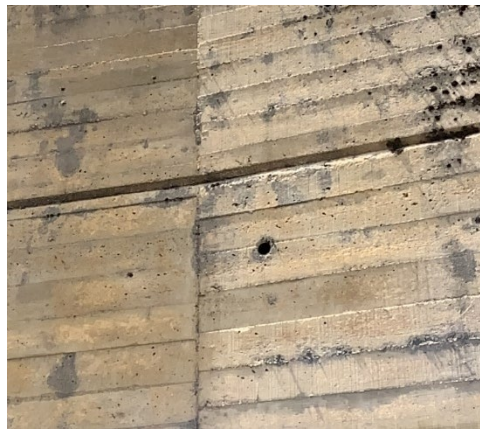
Ilustración 14- Mechinal en muro del estribo 2
