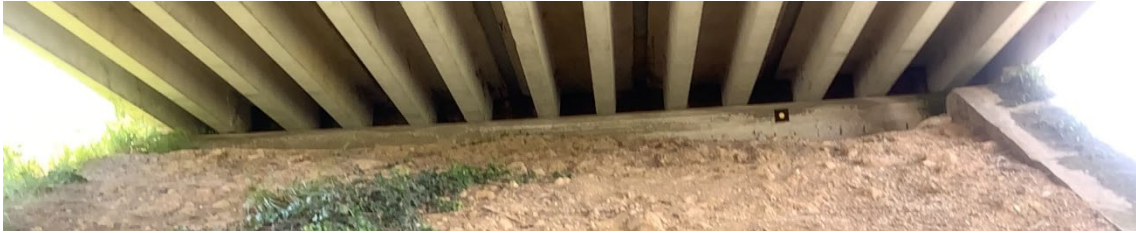
Ilustración 5- Dintel Cargadero del estribo 2
