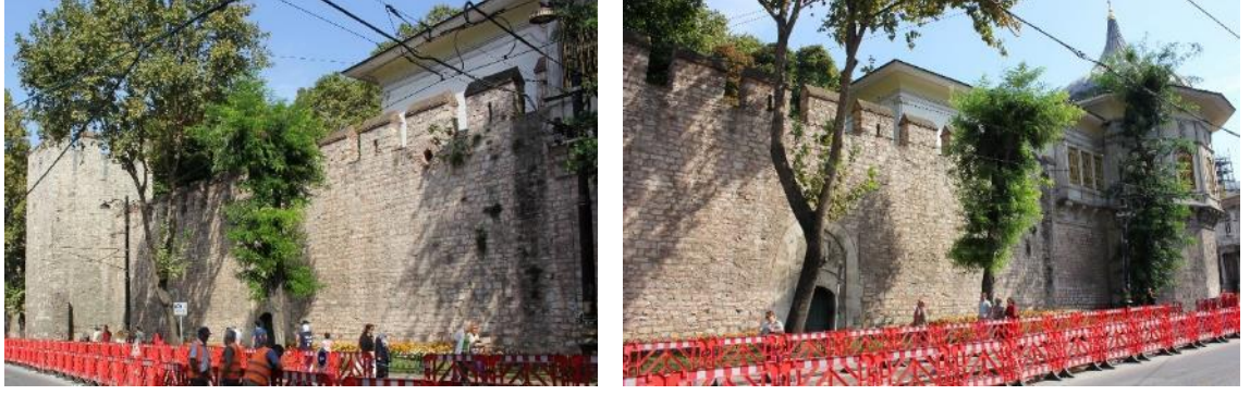
Şekil 3.192. Alay Köşkü ve 18 nolu burç arasındaki kısmın sur dışından genel görünümü (Soyal, 2015)
