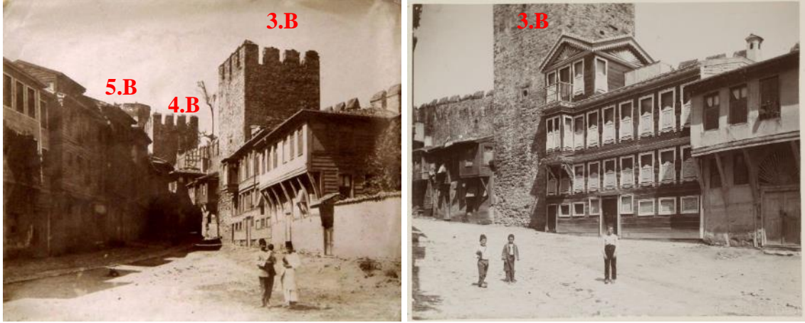
Şekil 3.45. Otluk Kapısından İshak Paşa Yokuşu istikametindeki kara suruna bitişik nizamda inşa edilmiş olan konut yapıları genel görünümü, (URL-14) 72
