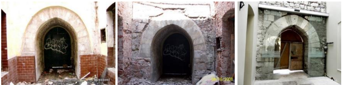
Şekil 3.223 Koltuk kapısına ilişkin restorasyon öncesi ve sonrası görüntüleri (İRAM).
