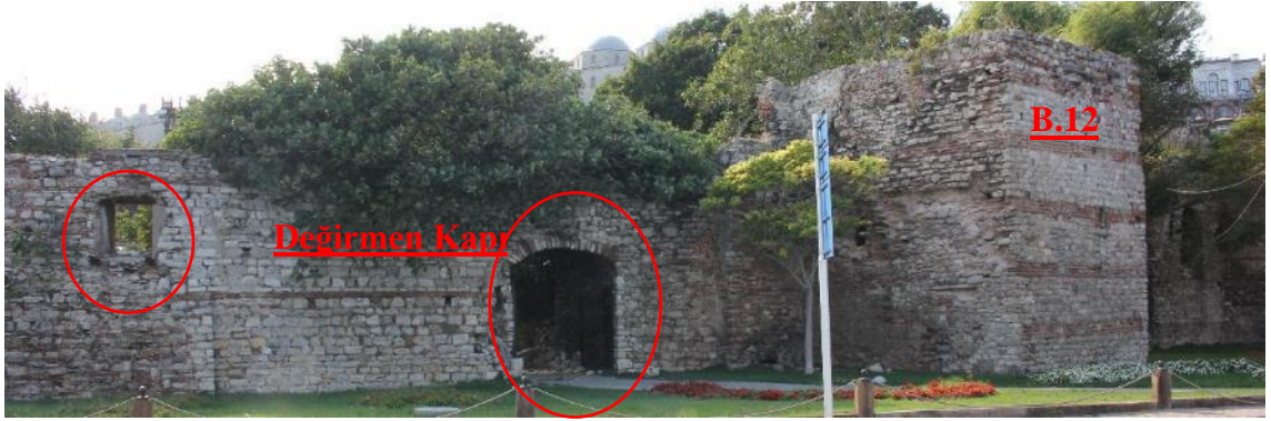
Şekil 3.352 B.12 ve B.11 istikametindeki sur duvarı genel görünümü (Soyal, 2016)
