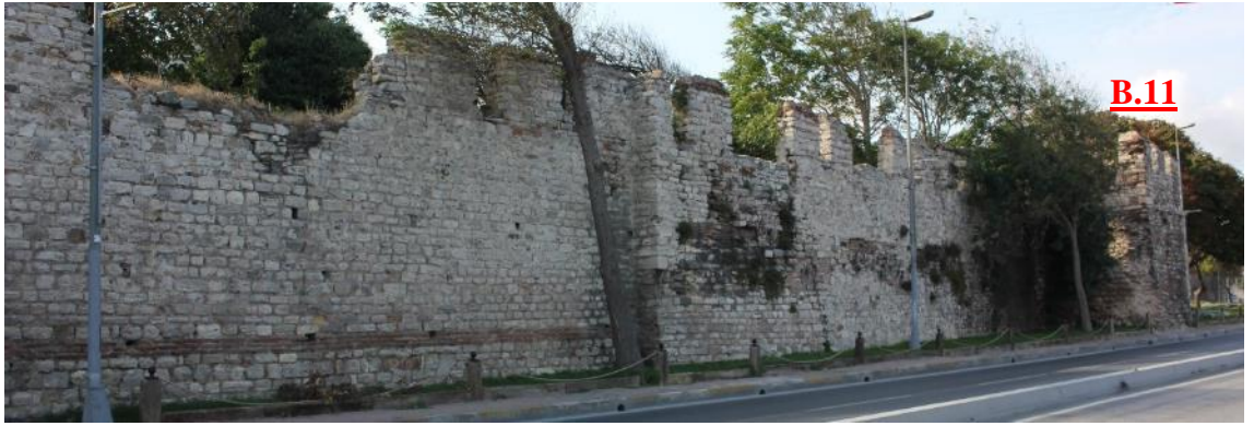
Şekil 3.368 B.10'dan B.11 istikametindeki sur duvarının devamına ilişkin genel görünüm (Soyal, 2016)
