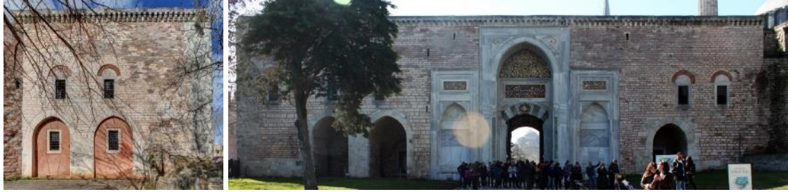
Şekil 3.105. Bab-ı Hümayun'un, sağ yan ve sarayın I. avlusuna bakan arka cephesi (sur içi).
