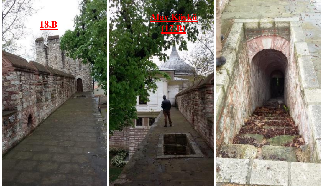
Şekil 3.195. Sur duvarı üzerinde seyirdim yolu, mazgal siperleri, top mazgalları ve merdivenlere ilişkin detay görüntümler (Soyal, 2015). 139
