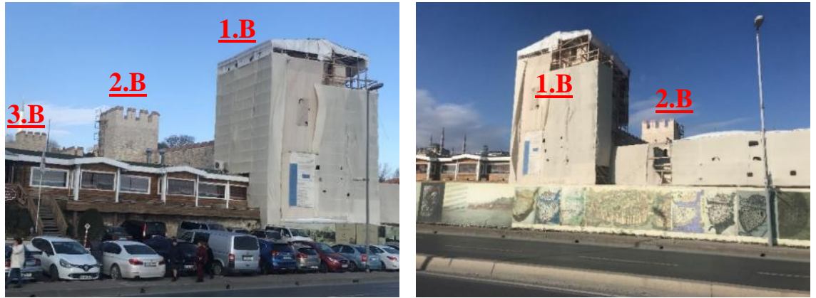
Şekil 3.34 Kara surunun 1 ve 2 nolu burçları (restorasyon aşamasında) ile sol tarafında Ahırkapı istikametindeki belediye sosyal tesislerine ait yapılar (Soyal, 2019). 62
