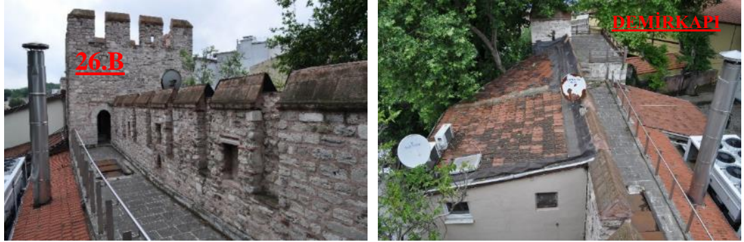
Şekil 3.273 26 nolu burç ile Demirkapı arasındaki kısım (İRAM)
