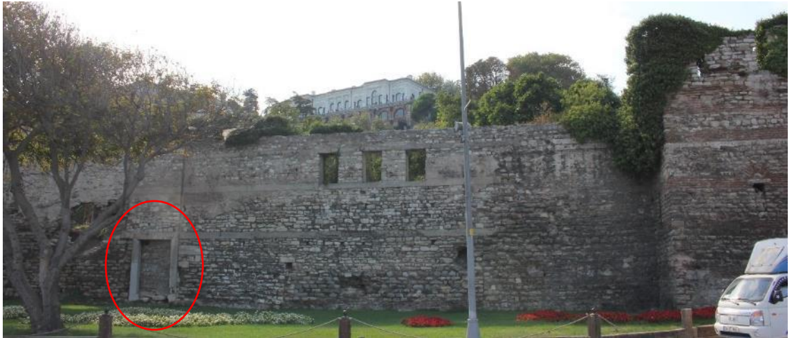
Şekil 3.321 B.15 ve B.14 burçları arasındaki sur duvarına ilişkin genel görünüm (Soyal, 2016) 195
