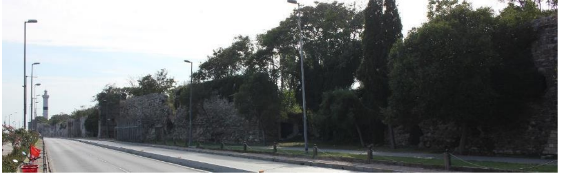
Şekil 3.397 B.8 ile Ahırkapı Feneri arasındaki sur hattından genel görünüm (Soyal, 2016)
