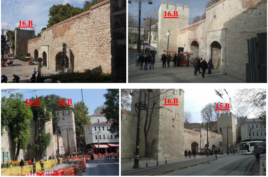
Şekil 3.155. 15 nolu burç ile 16 nolu burç arasındaki kısmın sur dışından genel görünümü (Soyal). 126
