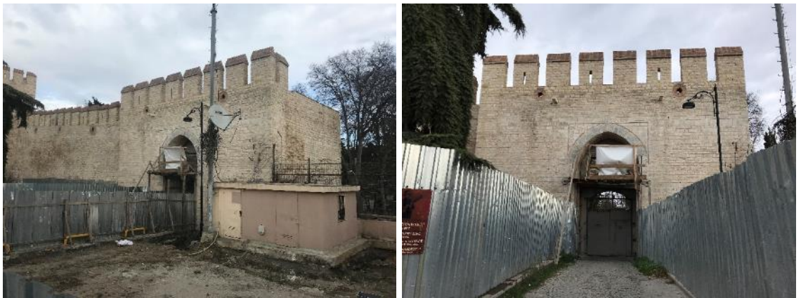
Şekil 3.52. Otluk Kapısının Genel Görünümü, Dış Cephe (Soyal, 2019).
