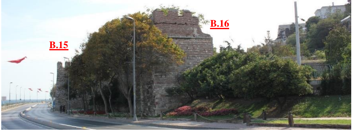
Şekil 3.319 B.16 ve B.15 burçları ile arasındaki sur duvarının genel görünümü (Soyal, 2016) 194
