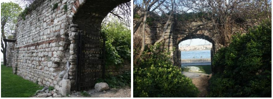
Şekil 3.354 Değirmen Kapıya ilişkin sur dışından ve içinden detay görünüm (Soyal, 2016)
