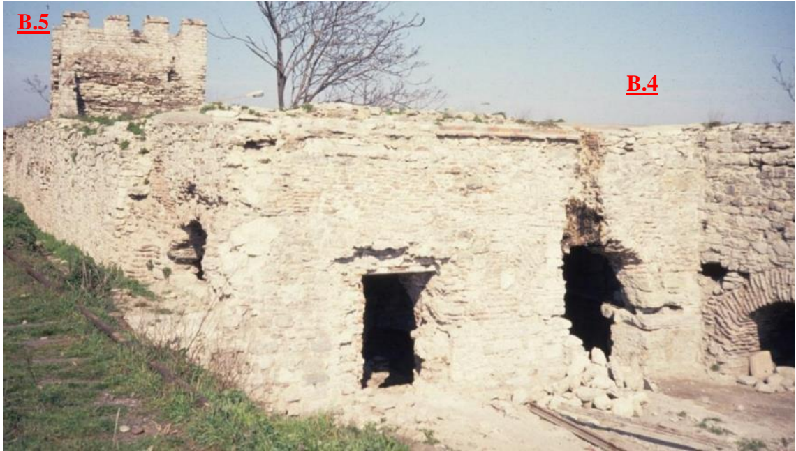
Şekil 3.453 Harap Köşk (B.4) ile B.5 arasındaki kısmın sur içinden restorasyon öncesi görünümü (İRAM)
