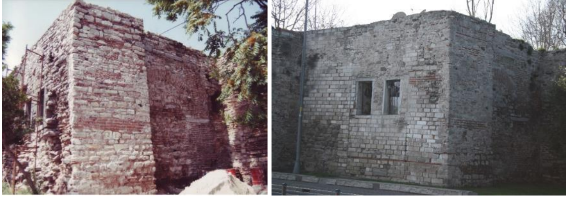
Şekil 3.452 Harap Köşk yapısının restorasyon öncesi (İRAM) ve sonrası (Soyal, 2016) görünüşleri.
