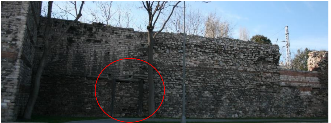
Şekil 3.431 B.5 ve B.6 arasındaki sur duvarına ilişkin detay görünüm (Soyal, 2016).
