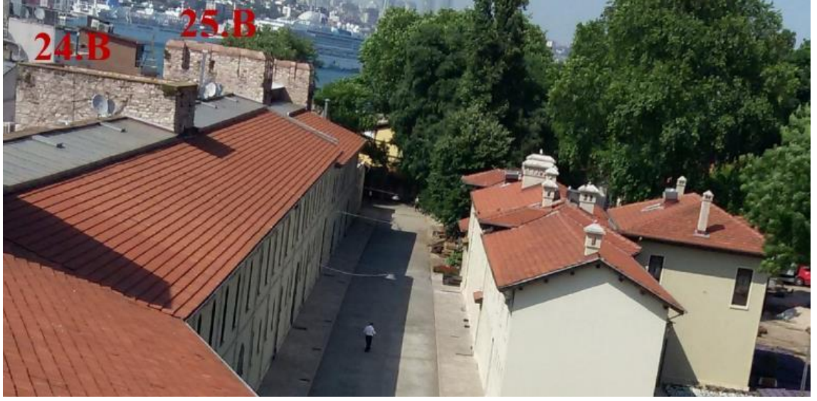
Şekil 3.255: 24 nolu burç ile 25 nolu burç arasındaki kısım (Soyal, 2015)
