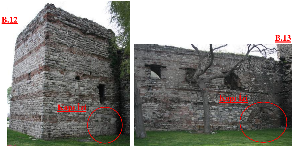
Şekil 3.347 B.13 ve B.12 burçları arasındaki kısımda yer alan kapı boşluğu izleri (İRAM)
