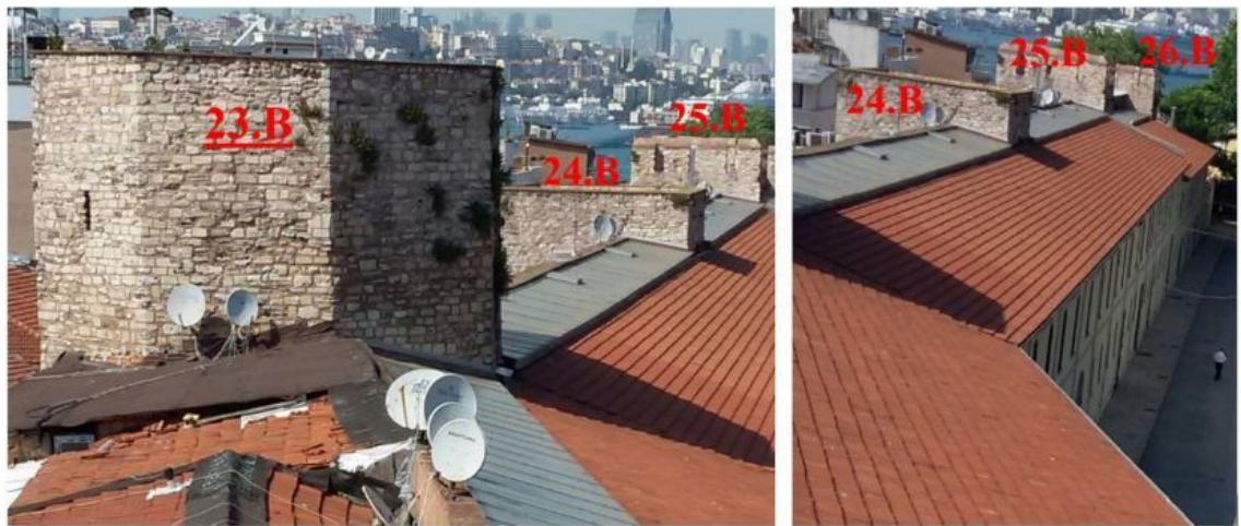
Şekil 3.246 23 nolu burç ile 24 nolu burç arasındaki kısım (Soyal, 2015)
