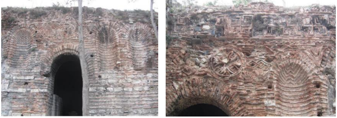
Şekil 3.380 Bizans yapı kalıntısına ilişkin nişler ve tuğla işçiliği detay görünümü (Soyal, 2016)
