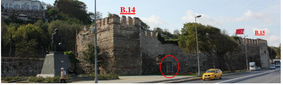
Şekil 3.322 B.14 ve B.15 burçları ile arasındaki sur duvarı genel görünümü (Soyal, 2016)
