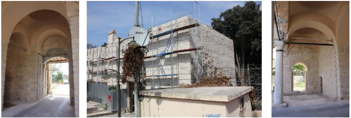
Şekil 3.55. Otluk Kapısı Girişi ve Arka Cephe Revakları Genel Görünüm (Soyal, 2016).
