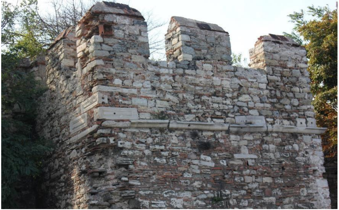
Şekil 3.357 B.11 burcu üzerinde korkuluk payelerinden oluşan devşirme malzeme. 209
