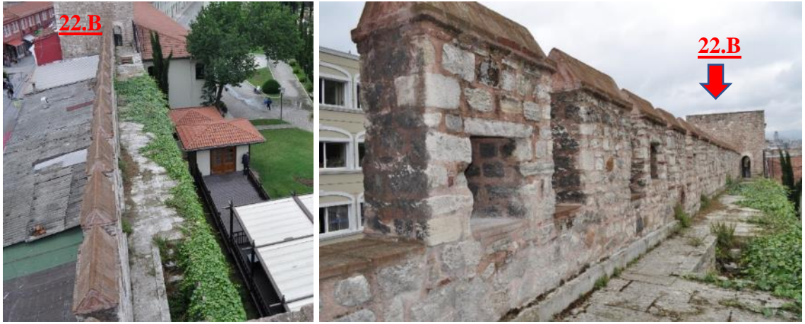
Şekil 3.227 21 nolu burç ile 22 nolu burç arasındaki kısım (İRAM). 147
