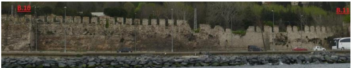
Şekil 3.364 B.11 ve B.10 arasındaki kısmın Marmara Denizinden siluet görünümü (İRAM)
