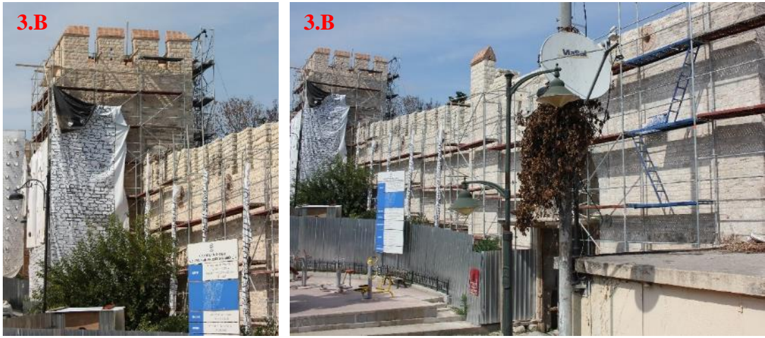
Şekil 3.46. Otluk Kapısından İshak Paşa Yokuşu istikametindeki kara suruna restorasyon çalışmaları aşamasındaki genel görünümü (Soyal, 2016) 73
