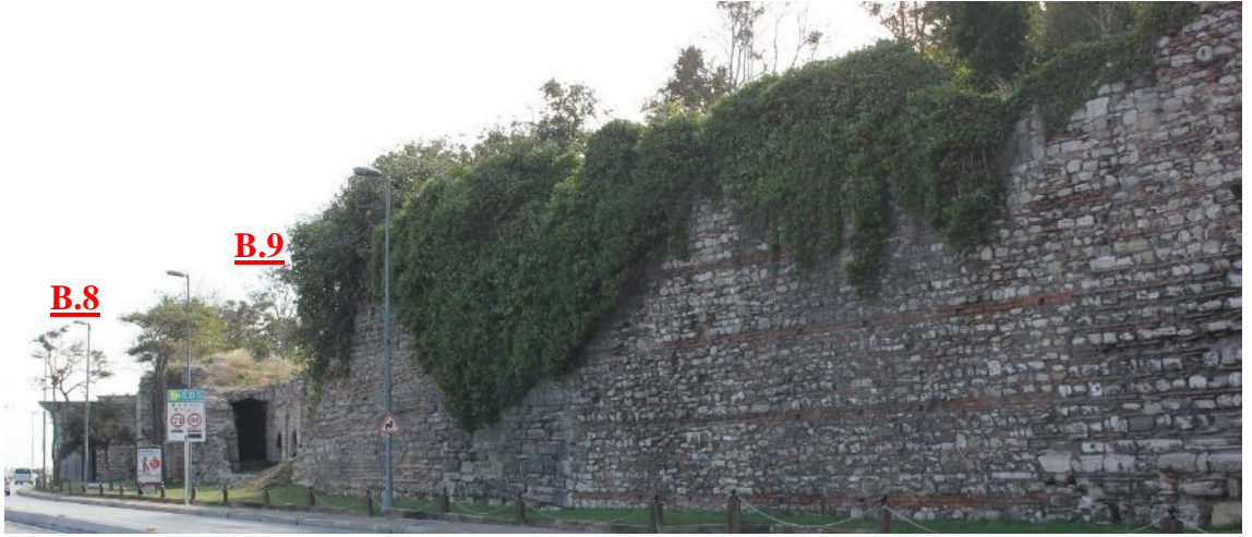
Şekil 3.383 B.9 ile B.10 arasındaki duvar görünümü (Soyal, 2016)
