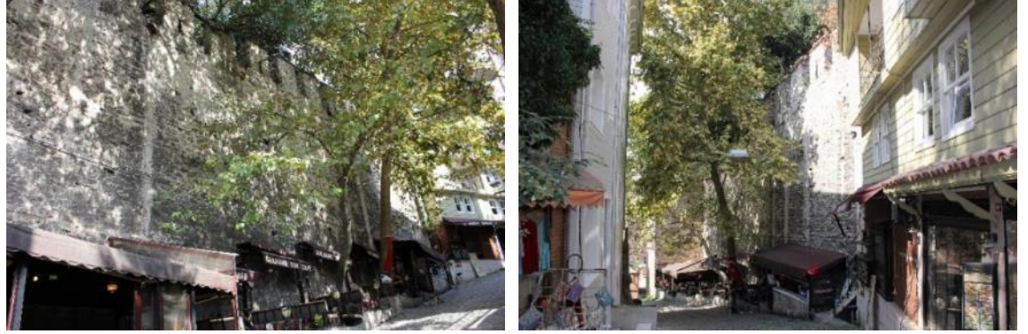
Şekil 3.147. 14 nolu burç ile 15 nolu burç arasındaki kısmın Soğuk Çeşme Sokak üzerinden genel görünümü (Soyal, 2016).
