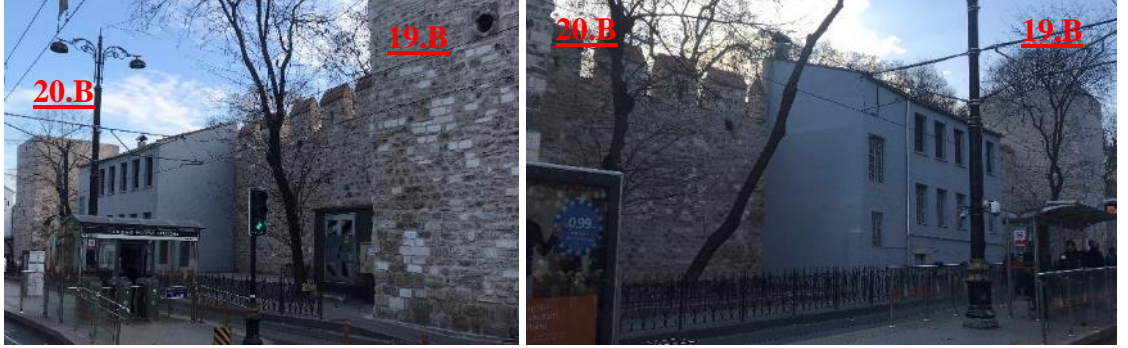
Şekil 3.208. 19 ve 20 nolu burç arasındaki kısmın sur dışından genel görünüşleri (Soyal, 2019).
