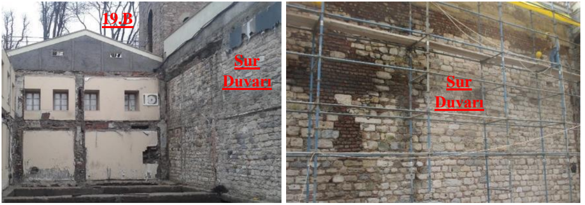
Şekil 3.212. Telgrafhane yapısı ve sur duvarı restorasyon aşaması görünümü (Soyal, 2017). 142
