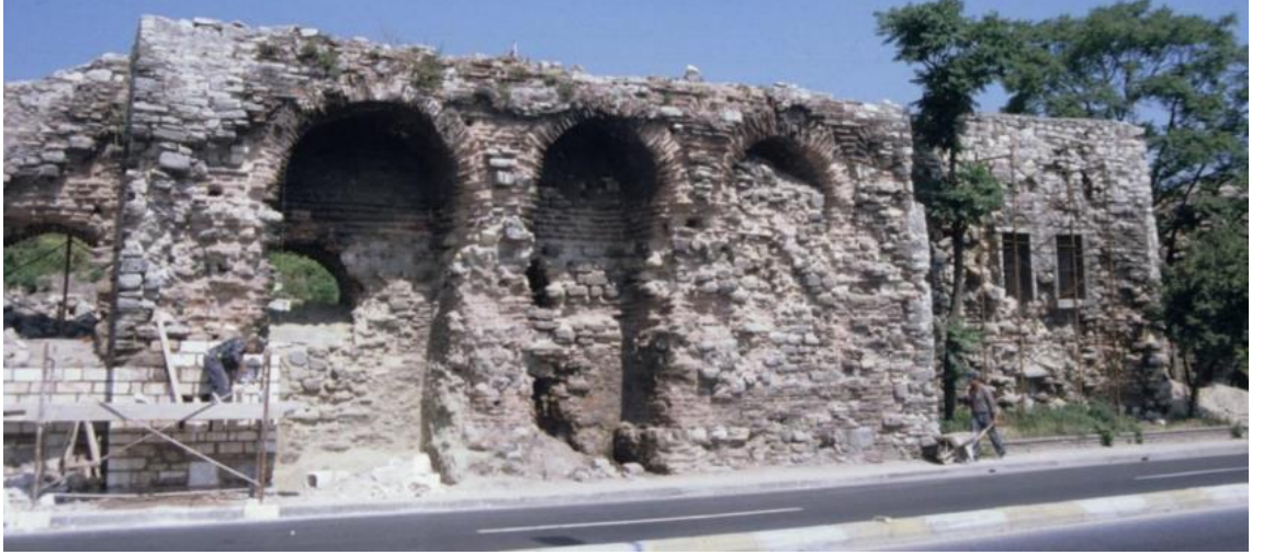
Şekil 3.450 Harap Köşk yapısının restorasyon öncesindeki görünümü (İRAM)
