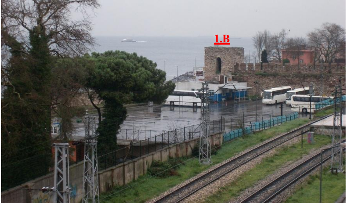
Şekil 3.39 Otobüs park alanı olarak kullanılan betonarme platform, (İRAM) 69
