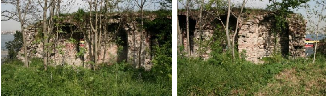
Şekil 3.424 B.7 ile B.6 arasındaki kısımda sur içi tarafında yer alan kazamat nişleri (Soyal, 2016)
