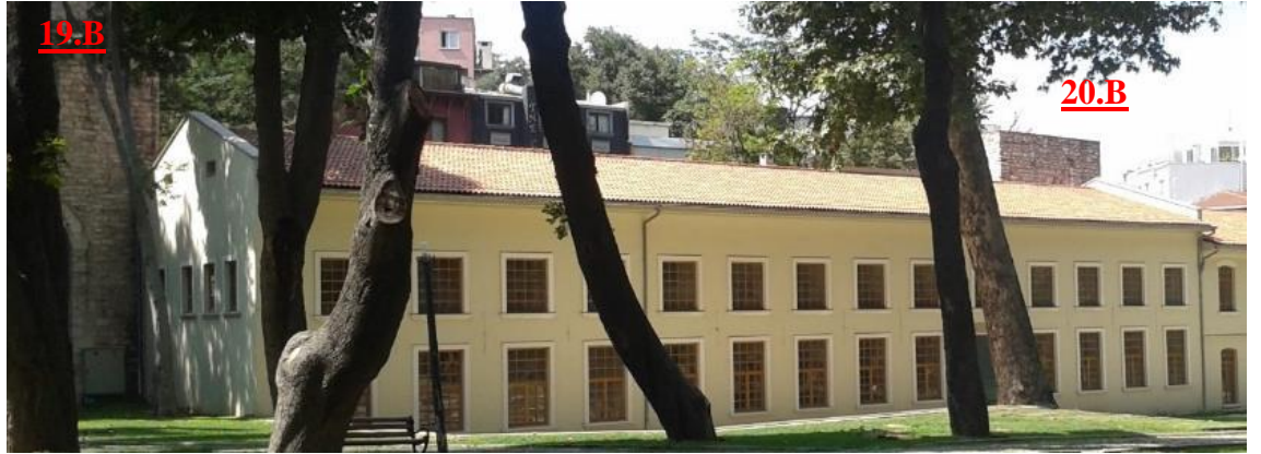
Şekil 3.210. 19 ve 20 nolu burç arasındaki kısmın sur içinden genel görünümü (Soyal, 2014).
