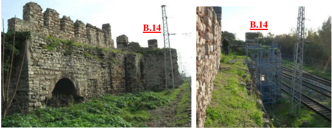
Şekil 3.325 B.14 ve B.15 burçları arasındaki kısmın sur içinden görünümü (İRAM)
