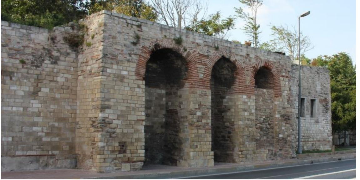
Şekil 3.451 Harap Köşk yapısının restorasyon sonrasındaki günümüz görünümü (Soyal, 2016) 235
