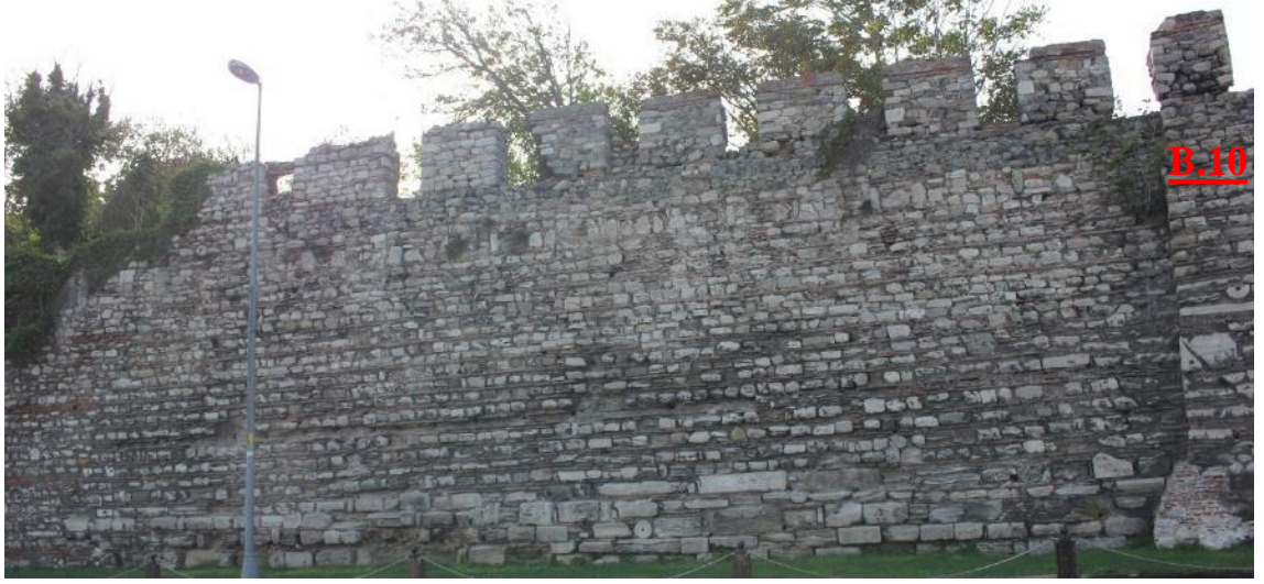
Şekil 3.382 B.9 ile B.10 arasındaki duvar görünümü (Soyal, 2016)
