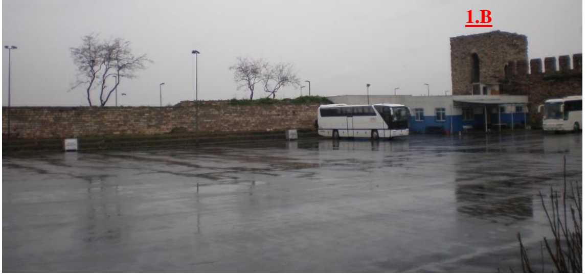
Şekil 3.40. Otobüs park alanı olarak kullanılan betonarme platform, (İRAM)
