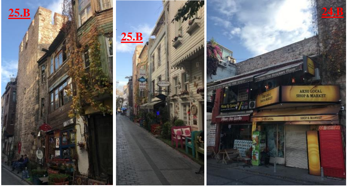
Şekil 3.257 24 ve 25 nolu burç arası sur dışından genel görünüm (Soyal, 2019)
