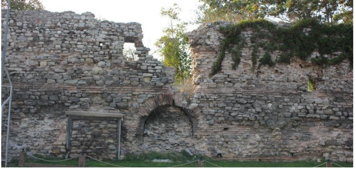
Şekil 3.423 B.7 ile B.6 arasındaki kısımda yer alan kapı izleri ve duvar örgüsüne ilişkin detay görünümü (Soyal, 2016)
