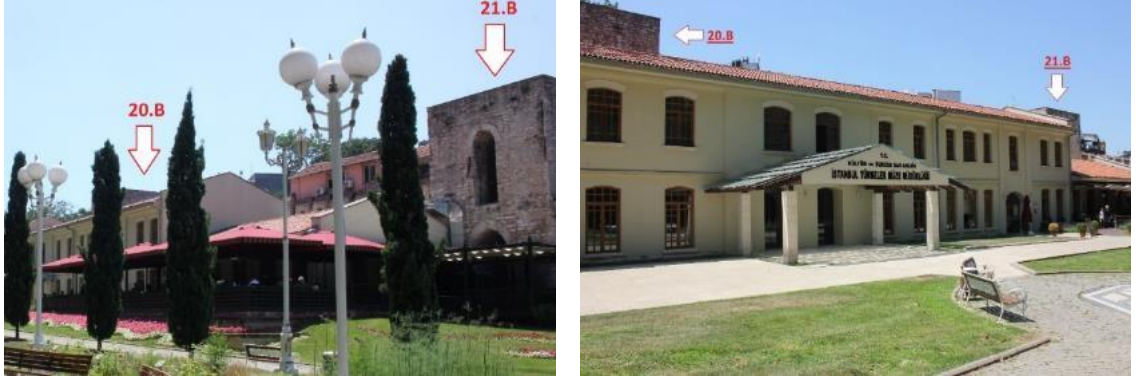
Şekil 3.221 20 ve 21 nolu burç arasındaki kısmın sur içinden genel görünümü (Soyal, 2016).
