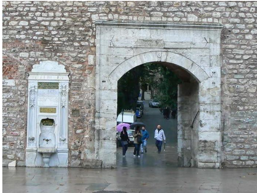
Şekil 3.165 Soğukçeşme Kapısı'nın sur dışından genel görünümü (URL-57).
