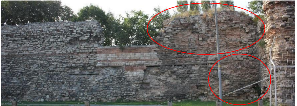
Şekil 3.430 B.5 ve B.6 arasındaki sur duvarına ilişkin detay görünüm (Soyal, 2016).
