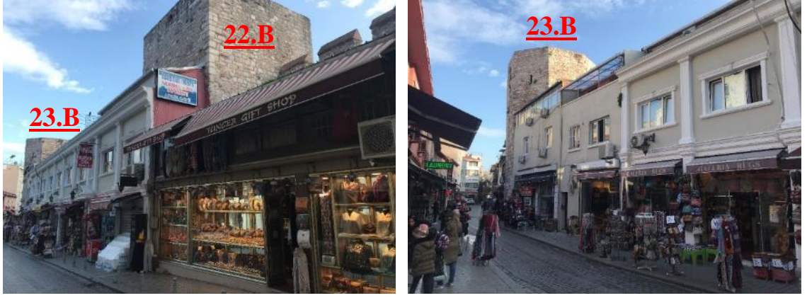
Şekil 3.238. 22 ve 23 nolu burç arası sur dışından genel görünüm (Soyal, 2019)
