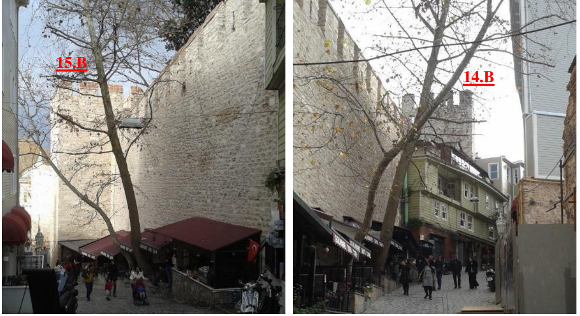
Şekil 3.148. 14 nolu burç ile 15 nolu burç arasındaki kısmın Soğuk Çeşme Sokak üzerinden restorasyon çalışmaları sonrasındaki genel görünümü (Soyal, 2019).
