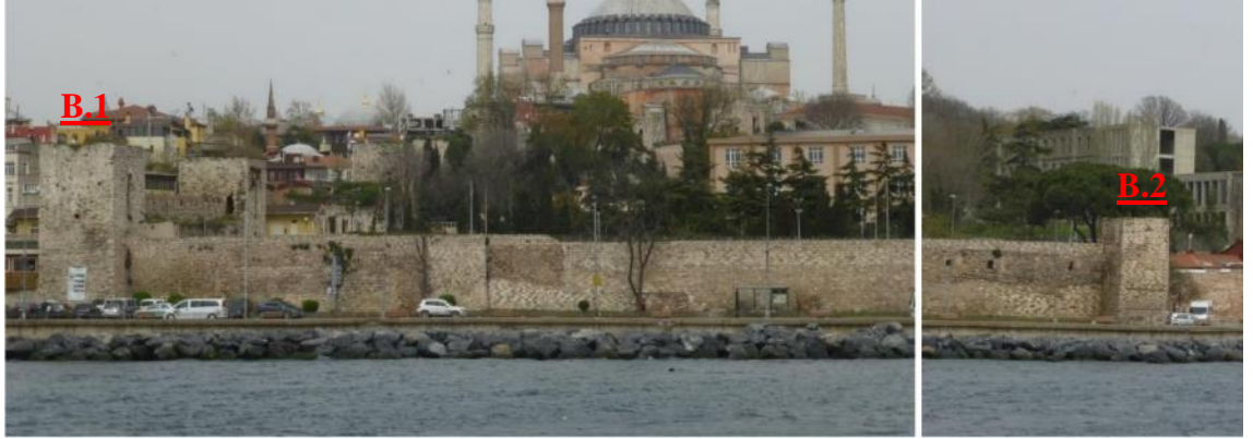
Şekil 3.490 B.2 ve B.1 arasındaki kısmın Marmara Denizinden siluet görünümü (İRAM)
