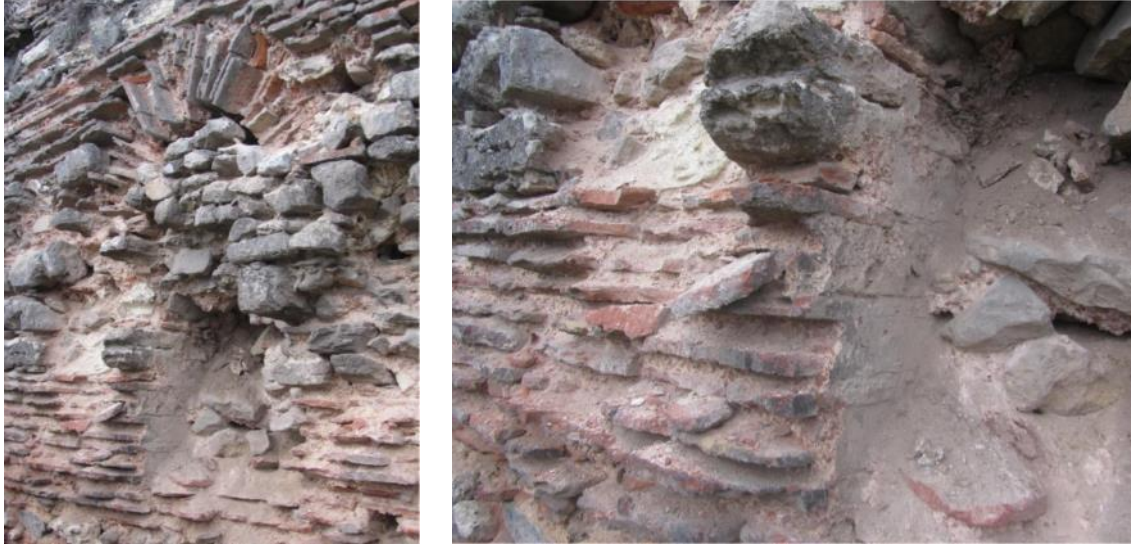
Şekil 3.367 Sur duvarı üzerindeki Bizans yapı kalıntısına ait kemerli pencere ve gizli tuğla tekniğindeki duvar dokusuna ilişkin detay görünüm (Soyal, 2016).
