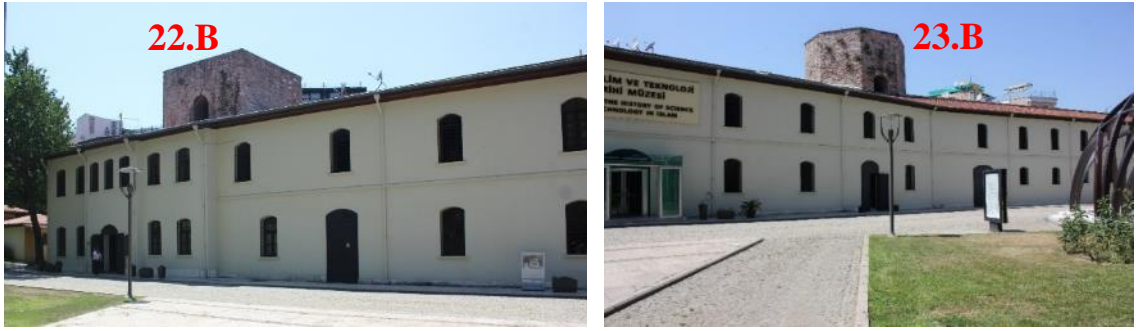
Şekil 3.241 22 ve 23 nolu burç arasındaki kısmın sur içinden genel görünümü (Soyal, 2015)
