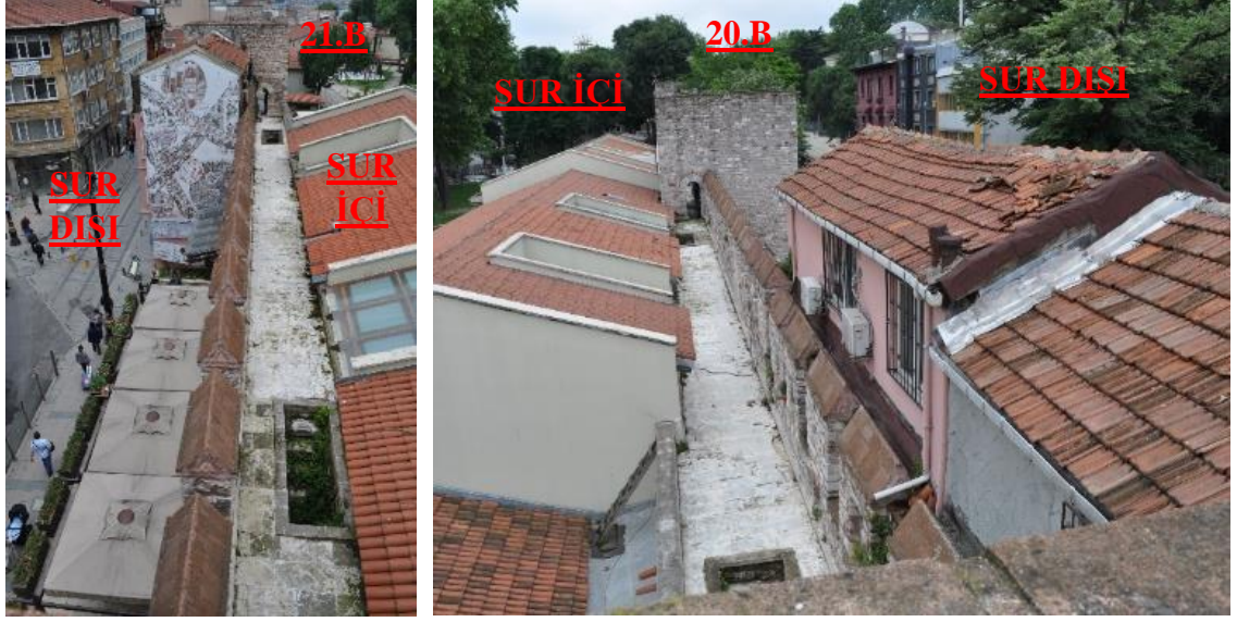
Şekil 3.215. Sur duvarı üzerindeki seğirdim yolu kotuna ilişkin detay görünüm (İRAM). 143
