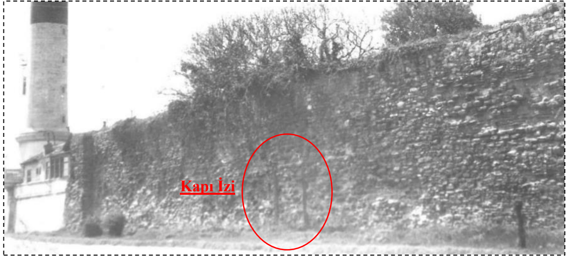
Şekil 3.463 Ahırkapı Feneri ve B.3 arasındaki kısıma ilişkin restorasyon öncesi görünüm (İRAM) 236
