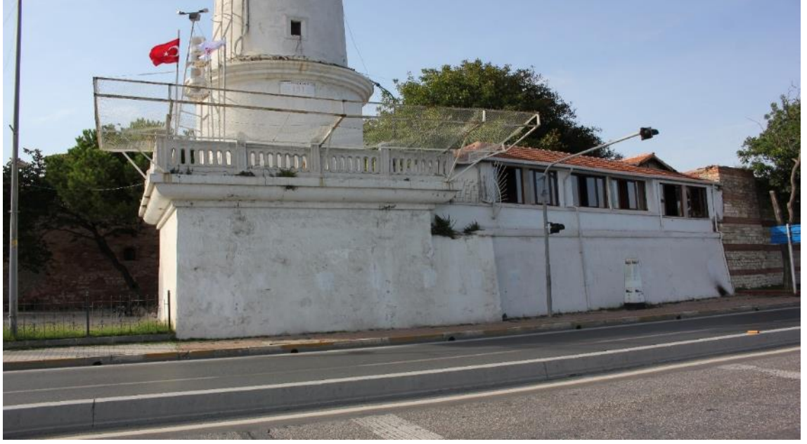
Şekil 3.464 Ahırkapı Feneri alt kısmının günümüz görünümü (Soyal, 2016). 237
