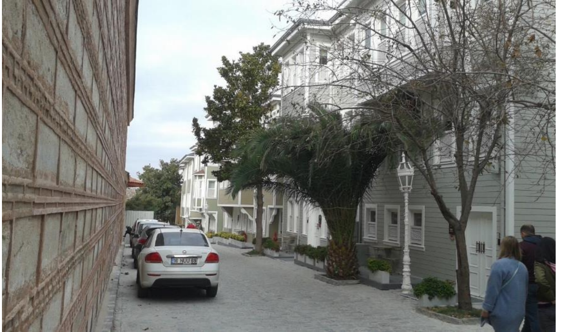
Şekil 3.124. 10 nolu burç önündeki konut yapısından Alay Köşkü istikametinde Soğuk Çeşme Sokaktaki sur önü yapılanmaların genel görünümü (Soyal, 2019).
