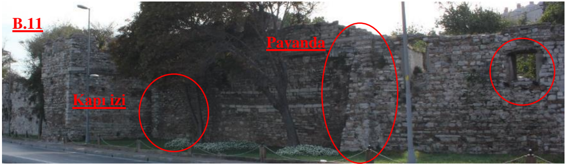
Şekil 3.353 B.11 ve B.12 istikametindeki sur duvarı genel görünümü (Soyal, 2016)
