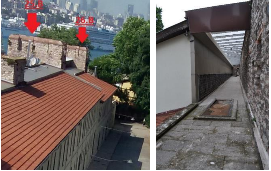
Şekil 3.263 25 nolu burç ile 26 nolu burç arasındaki kısım (Soyal, 2015)
