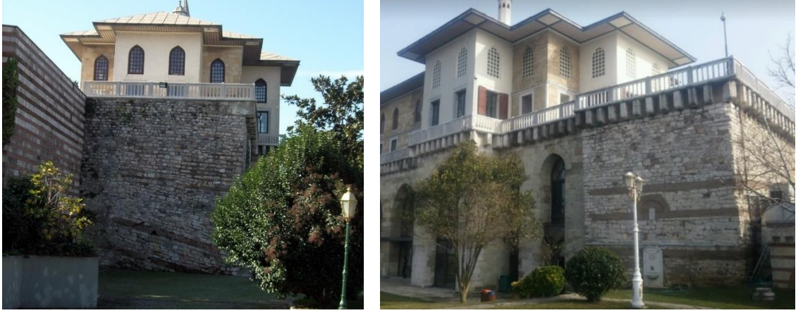
Şekil 3.302 Sepetçiler Kasrı'nın alt kısımlarındaki geçmiş dönem sur izleri (URL-46)
