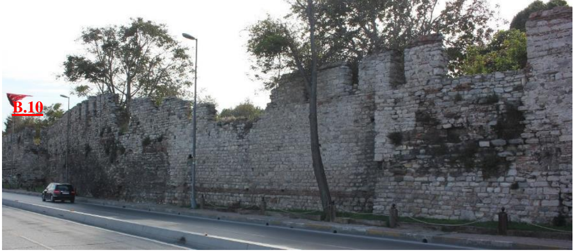
Şekil 3.365 B.10'dan B.11 istikametindeki sur duvarı genel görünümü (Soyal, 2016)
