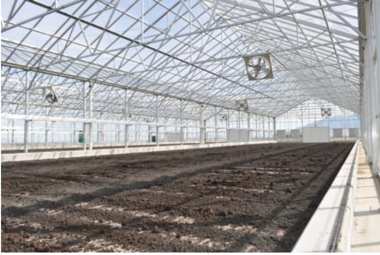
Şekil 14. Güneş Enerjisi ile Çamur Kurutma
