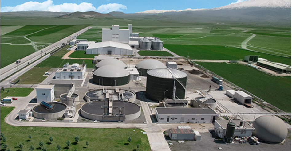
Şekil 7. Aksaray'da bulunan Türkiye'nin en büyük biyogaz tesisi
