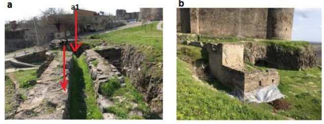
Şekil 3. Hevsel Bahçeleri Değirmen II; a) Üstten görünüm a1; Depolama haznesi a2; Değirmen Kanalı, b) Yandan görünüm
