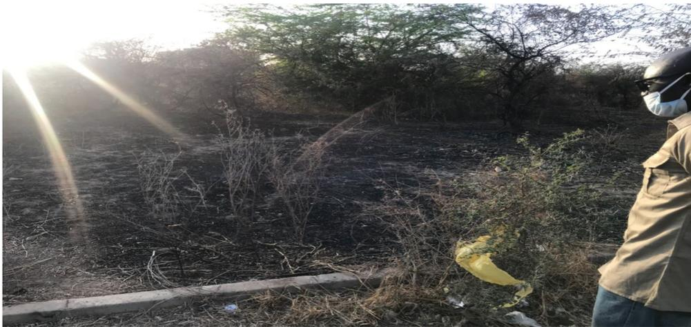
**Figure 1.5 Débris d'un feu enclenché par les travailleurs de la construction comme méthode de désherbage à Thiès, Zac Nguinth (Photographié par Seck, 2021)**
