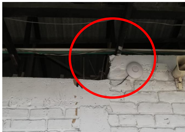
Figura 10: Viga corta Fuente: Propia
