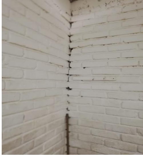
Figura 1: Muros sin confinar Fuente: Propia
