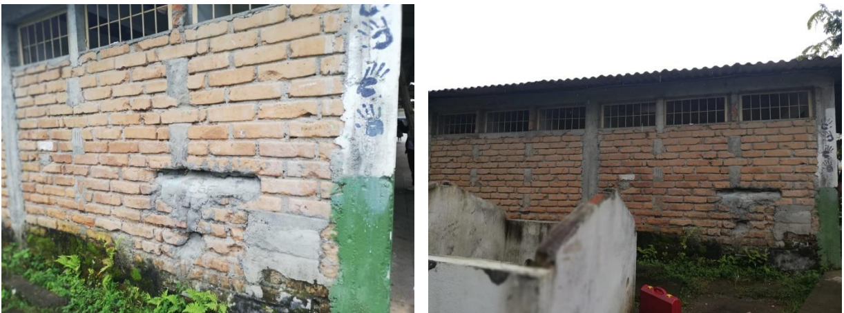
Figura 2: Elementos estructurales no continuos Fuente: Propia
