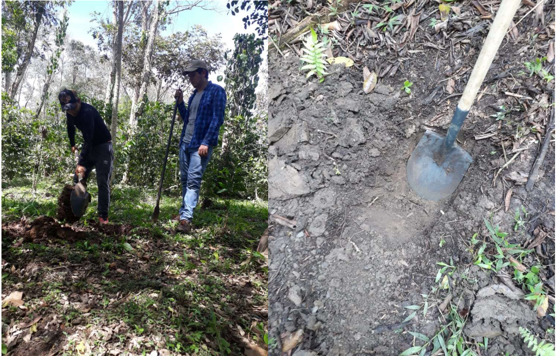
Ilustración 7 Descapotado y excavación en forma de v
