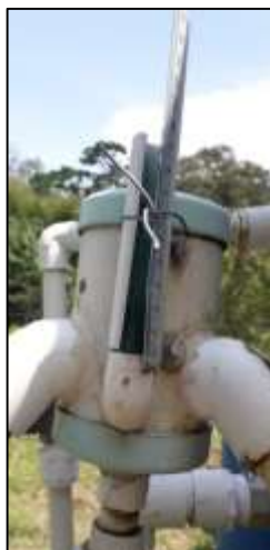
Medición línea piezométrica
