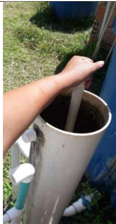
Fotografía 10. Lavado de filtros.
