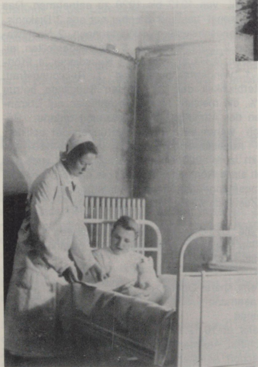
Abb. 11 Ein vom Schwamm befallenes Patientenzimmer in der alten Kinderklinik
