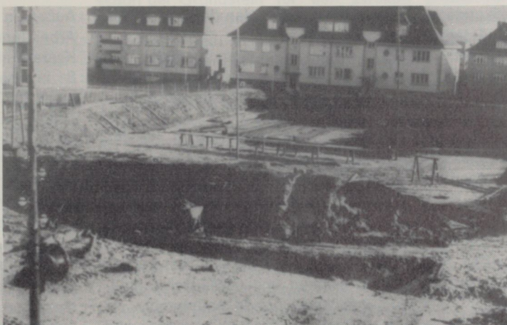
Abb. 12 Baugrube für den Neubau der Universitäts-Kinderklinik (1938)
