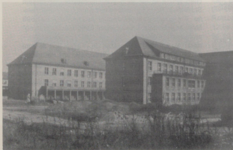
Abb. 15 Der Nord- und Mittelflügel des Neubaus
