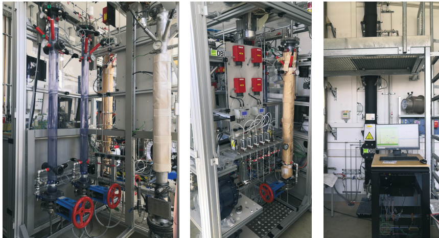
Abb. 3: links und Mitte: Versuchsanlage im Labormaßstab, rechts: Pilotanlage
