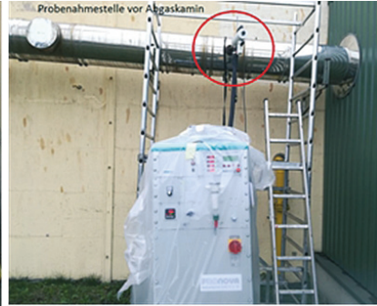
Abb. 6b: Probenahmestelle vor Rauchgaskamin
