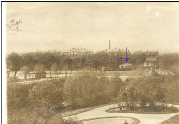
Abb. 77: Baracke für Haut- und Geschlechtskranke (lila Pfeil) auf dem Gelände des Univ.-KH vor 1908.
