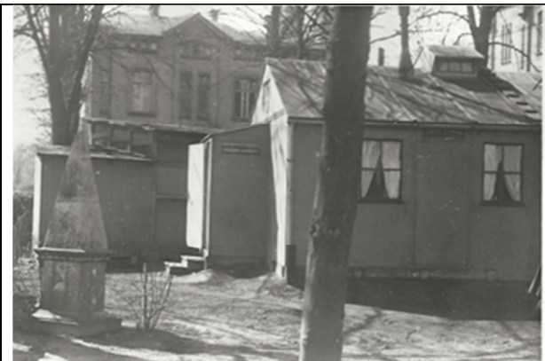
Abb. 78: Baracke für Scharlach-Kranke 1941, dahinter Bretter-Baracke für Tbc-Kranke und die Hautklinik.
