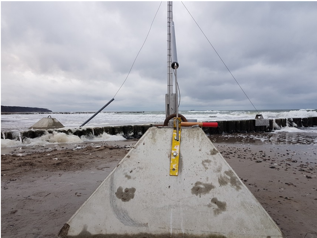
ABBILDUNG A.1: Betongewichte zur seitlichen Abspannung (Foto: Christian Kaehler).
