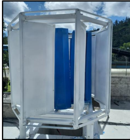
Fig. 37. Instalación del generador eólico
