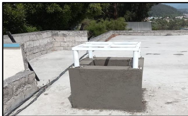
Fig. 36. Base de hormigón para el aerogenerador
