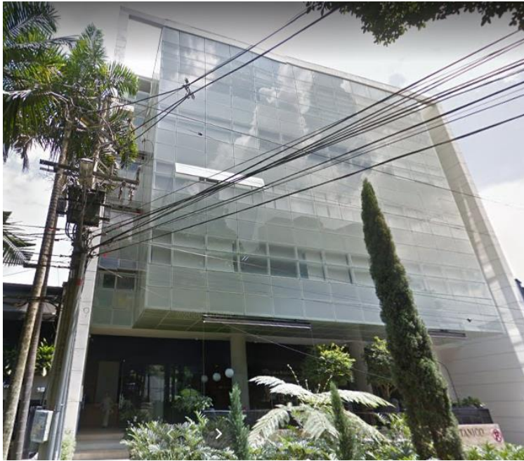
Figura 24: Edificio Bianco- oficina Brinsa en Provenza
