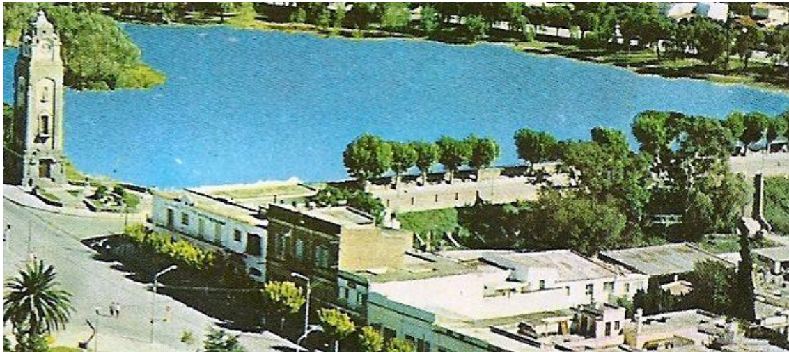
Figura 2. Vista del Tajamar, del Reloj y del sitio en donde se ubicaba el Hotel Plaza contiguo al edificio Municipal en la década de 1960.
