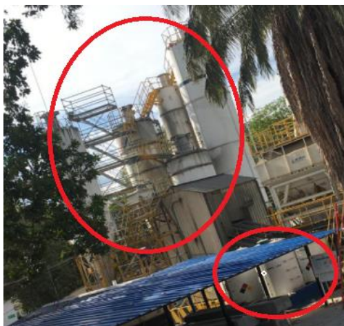
Ilustración 5: Silos almacenamiento cemento, ceniza y aditivos
