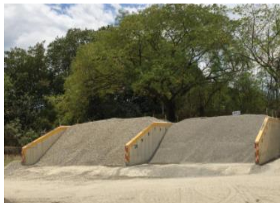
Ilustración 6: Cubículos acopio de MTP arena, grava 1" y grava ½
