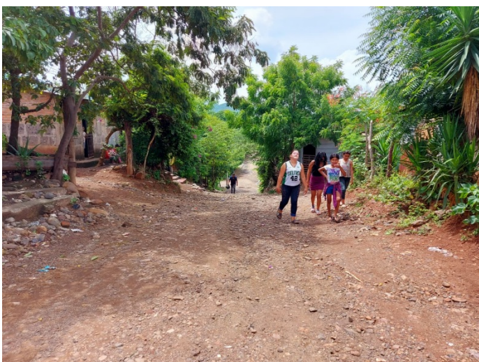
Ilustración 3 Foto de la calle principal del barrio El Porvenir sector 2, municipio de Sébaco
