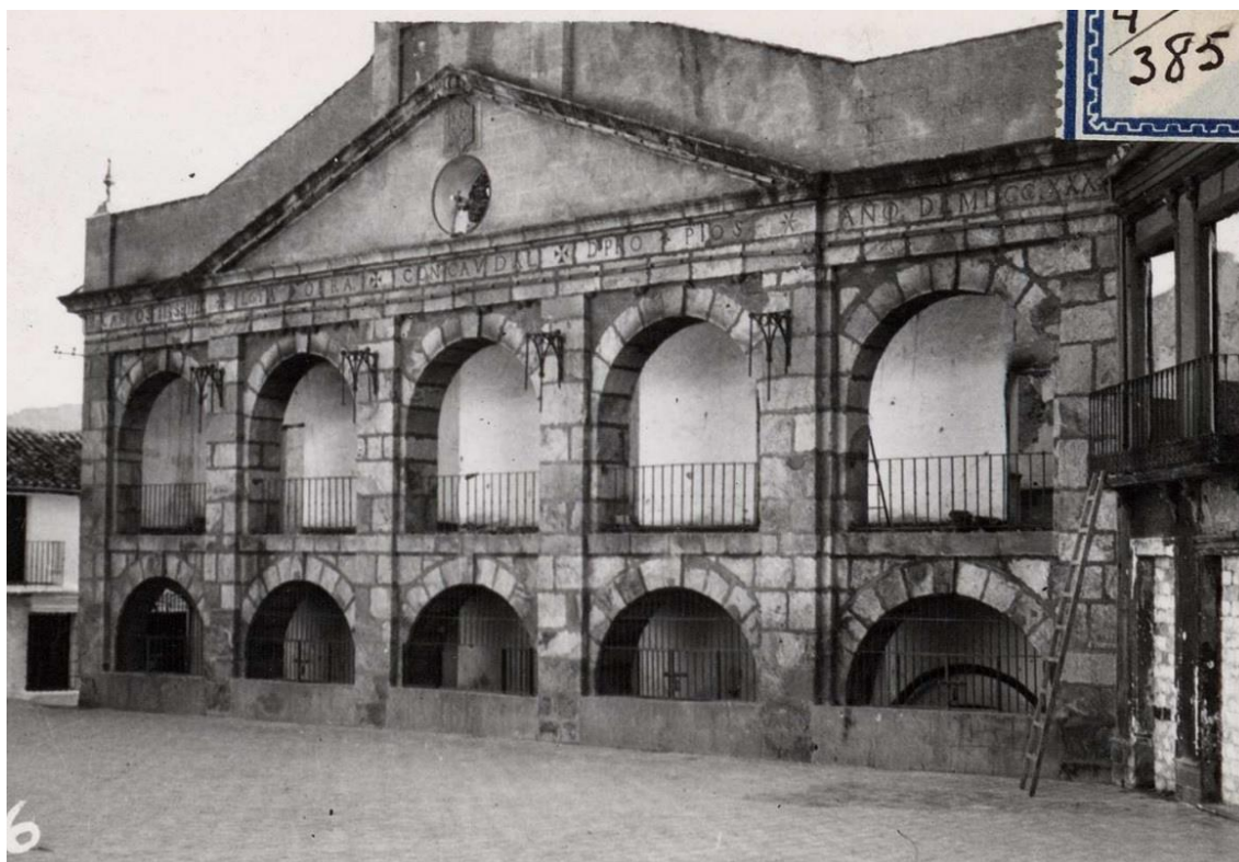
Fotografías nº 2 a nº 5: Cortes de la Frontera, ayuntamiento y cárcel después del incendio
