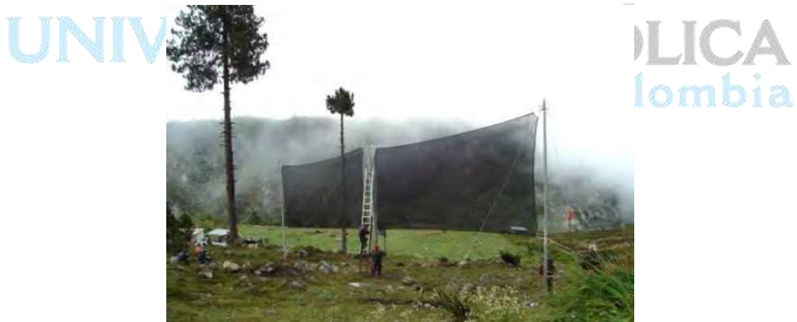
Ilustración 8: Estructuras “Atrapanieblas” instalados en Tojquia a 3300 msnm
