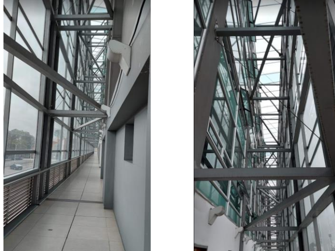
Ilustración 41. Primera y segunda piel de la edificación. Fuente: Elaboración propia
