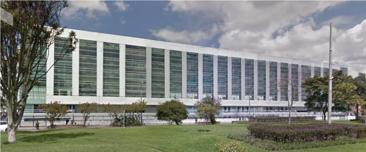
Ilustración 3. Fachada norte-Envolvente-Materialidad. Edificio Aydeé Anzola-Bogotá.
