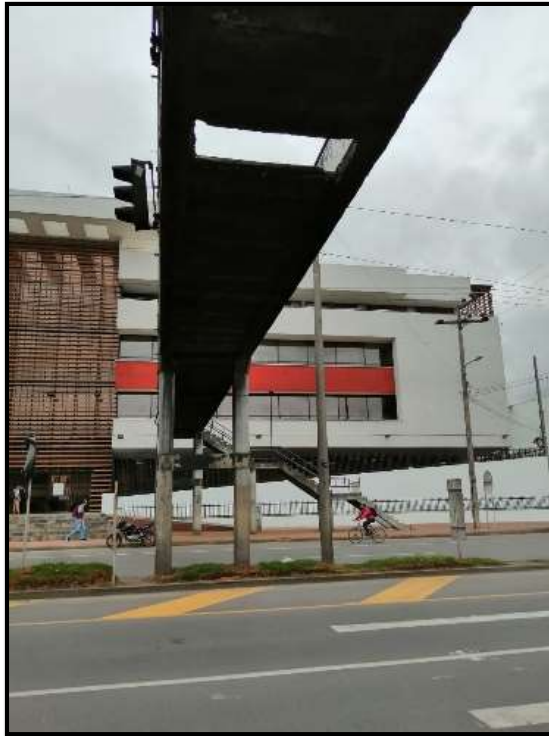
Imagen 15: Estado actual del puente peatonal
