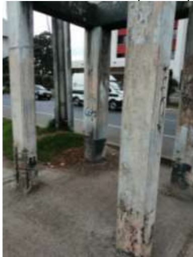
Imagen 1: Estado actual del puente peatonal
