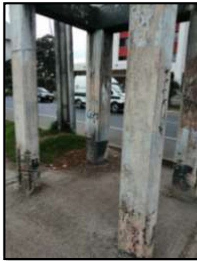
Imagen 1: Estado actual del puente peatonal
