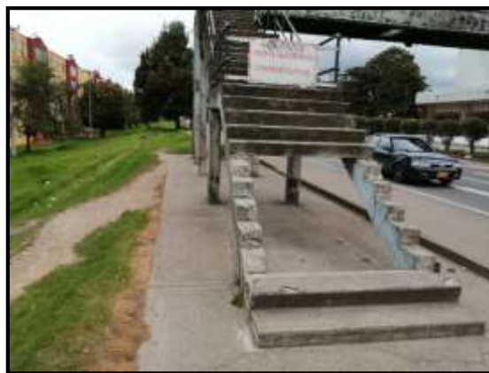
Imagen 12: Estado actual del puente peatonal
