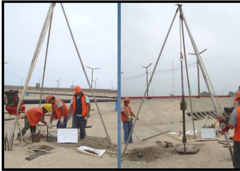
Ilustración 6: Ensayo de suelos - SPT
