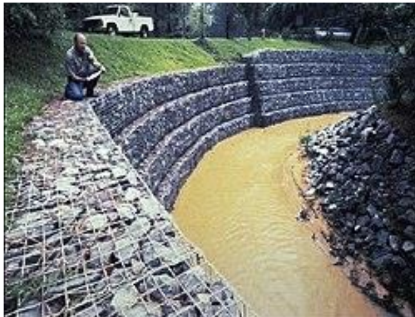
Ilustración 25. Gaviones en el Cauce.
