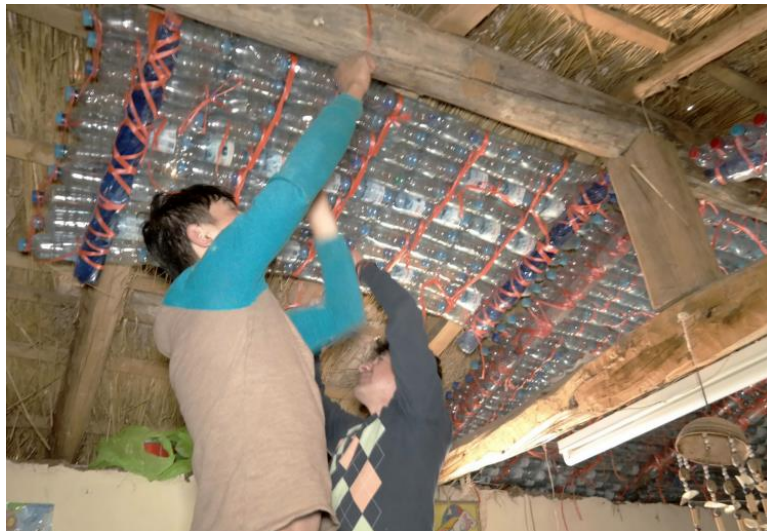
Figura 4. Fotografía de instalación del sistema de confort térmico para las viviendas del alto andino peruano. Fuente: Moncloa (2017). CC BY 4.0
