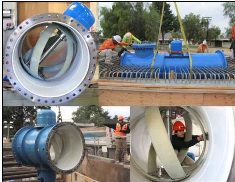
Ilustración 8 Construcción de microturbina.
