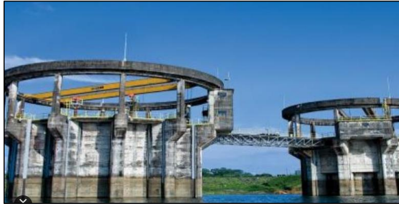
Ilustración 13 Hidroeléctrica san Carlos
