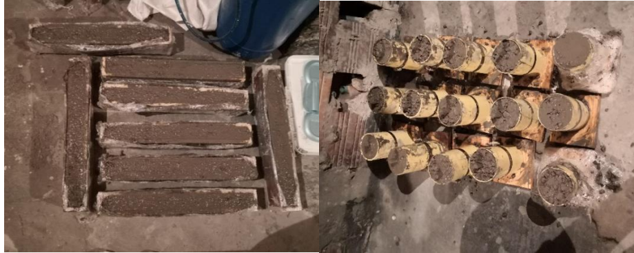
Fotografía 14. Muestras de concreto fraguando.
