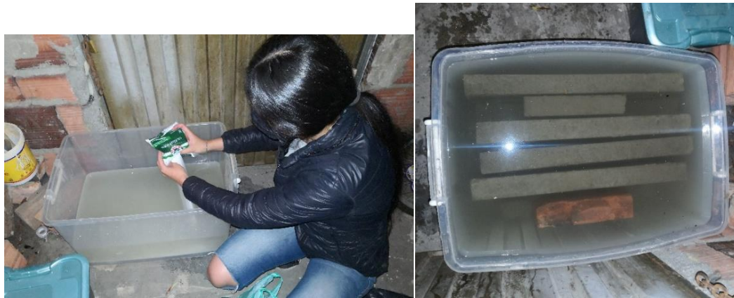
Fotografía 17. Curado de viguetas en agua con sal.
