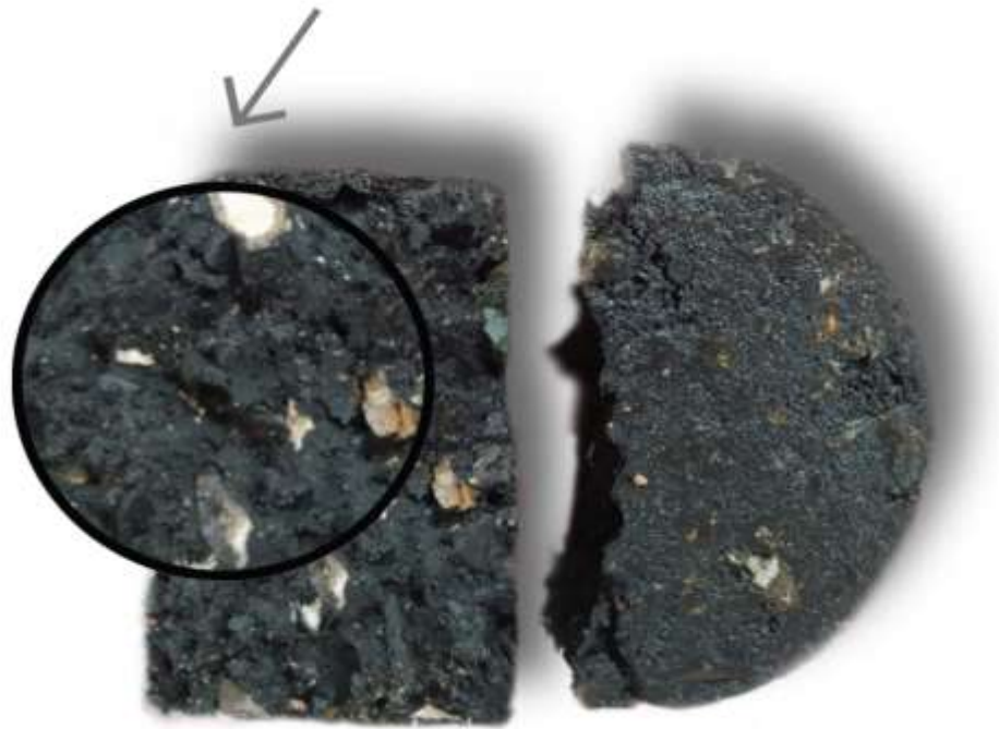
Figura 18. Daño por humedad en la mezcla con adición de cal hidratada.
