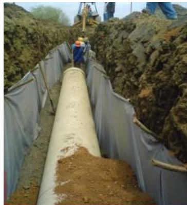
Figura 36 Relleno para estructuras con recebo
