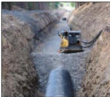
Figura 34 Relleno con gravilla
