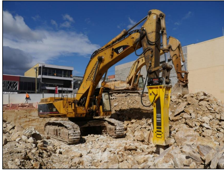
Figura 29 Demolición de pavimentos rígidos
