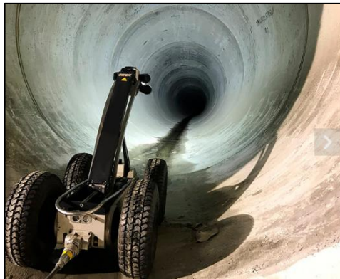
Figura 42 Inspección con CCTV
