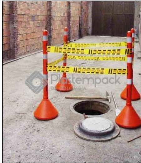
Figura 27 Instalación de cerramiento Fuente: https://plastempack.com/producto/59
