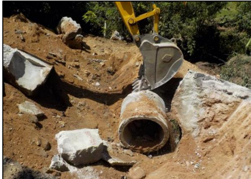
Figura 33 Demolición y retiro
