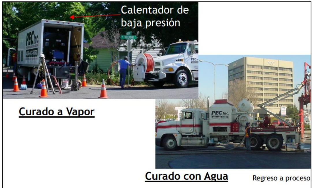
Figura 45 Curado de la resina con calor (agua o vapor)
