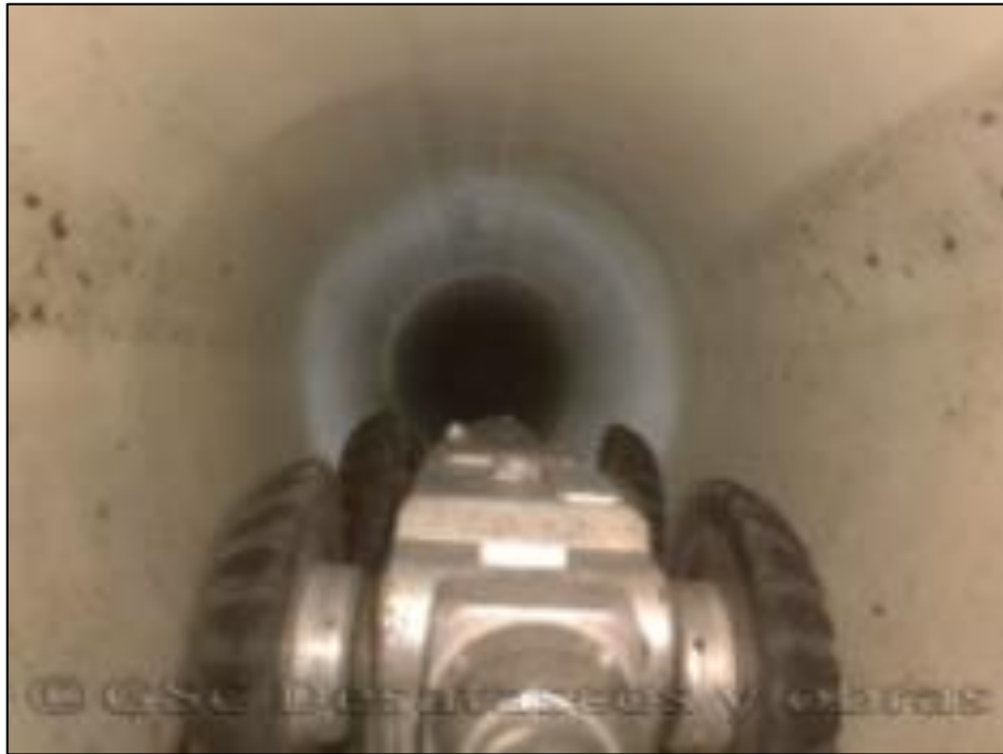
Figura 47 Inspección con CCTV
