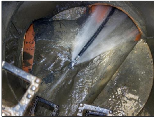
Figura 41 Lavado de la tubería
