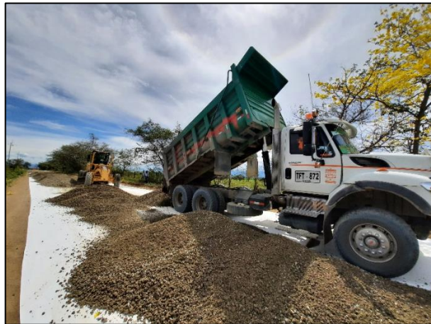
Figura 39 Relleno Sub Base Granular clase A
