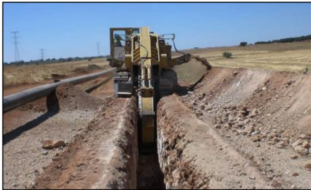
Figura 31 Excavación a máquina y retiro
