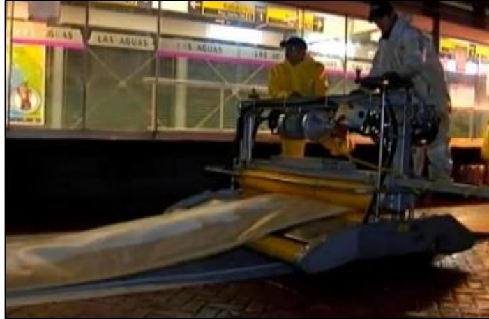
Figura 43 Impregnación -resina epóxica
