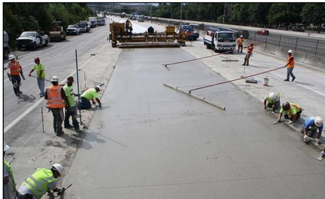
Figura 40 Pavimento de concreto hidráulico
