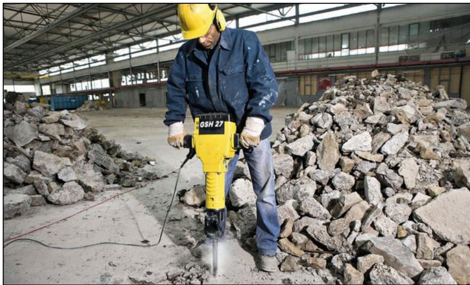
Figura 30 Demolición de pavimentos rígidos
