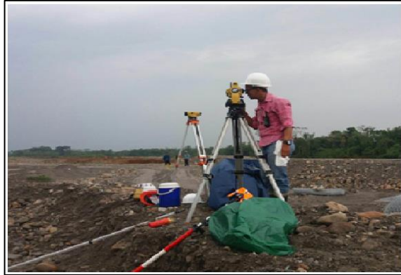
Figura 25 Localización y replanteo
