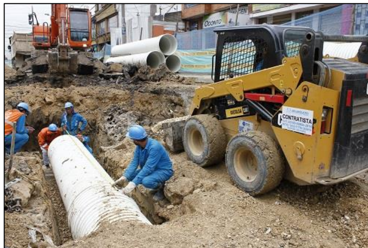
Figura 1 Rehabilitación de redes de alcantarillado a zanja abierta en la localidad de Engativá Fuente (Empresa de Acueducto y Alcantarillado, s.f.):
