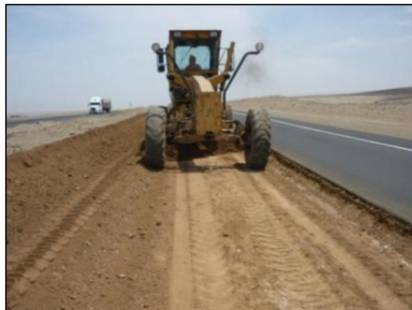
Figura 38 Relleno Base Granular clase A
