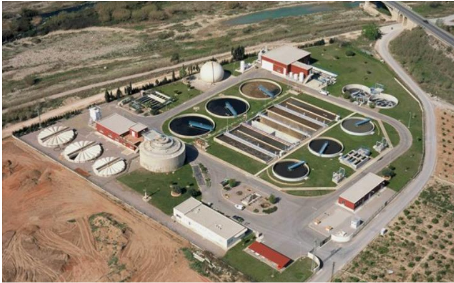
Figura 8.7.3. Vista detalle EDAR Almazora
