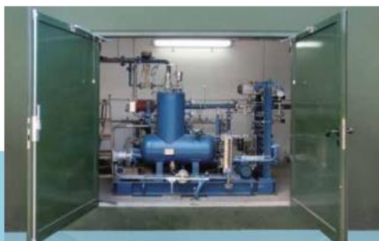
VMX 110 de AERZEN para comprimir biogás y biometano
