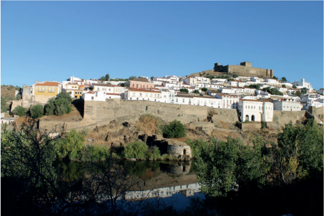
Figura 1: Vista general del núcleo patrimonial principal de Mértola, entre el que sobresalen el Alcázar y la antigua Mezquita.
