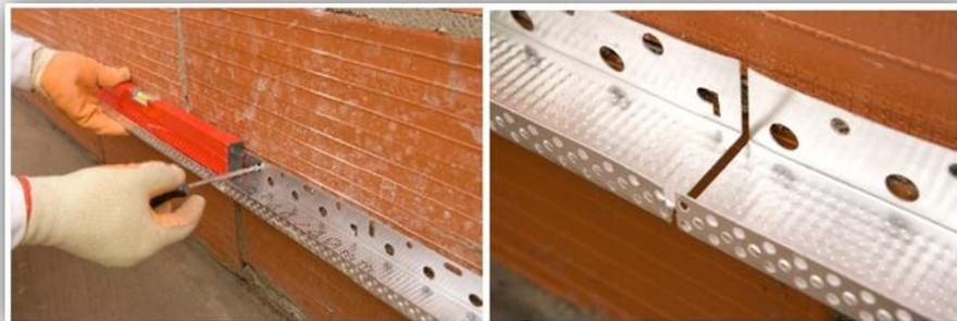
El perfil de arranque deberá posicionarse por lo menos 15 – 20 cm del suelo, para que el sistema de aislamiento no entre en contacto directo con el suelo. El perfil deberá ser colocado en posición horizontal, utilizando para su fijación tornillos de zinc y tacos adecuados al soporte, con una distancia de fijación entre ellos inferior a 30 cm, y colocando una fijación a menos de 5 cm en los extremos. En las uniones entre perfiles deberá existir un espacio de 2–3 mm para permitir su dilatación.
