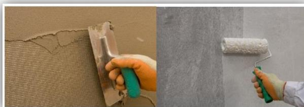
Cuando la última capa de **weber.therm base** esté completamente seca, mínimo 24 horas después de su aplicación en función de las condiciones meteorológicas, se aplica **weber CS plus**, imprimación de fondo y regularizador de la absorción. Este producto se extiende con un rodillo o una brocha en 2 manos cruzadas, y debe presentar una coloración similar a la del revestimiento final. Es importante que esta capa sea uniforme en términos de coloración y textura.
